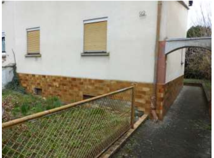
Ansicht Gebäude, Vorgarten und Fußweg zur Haustüre
