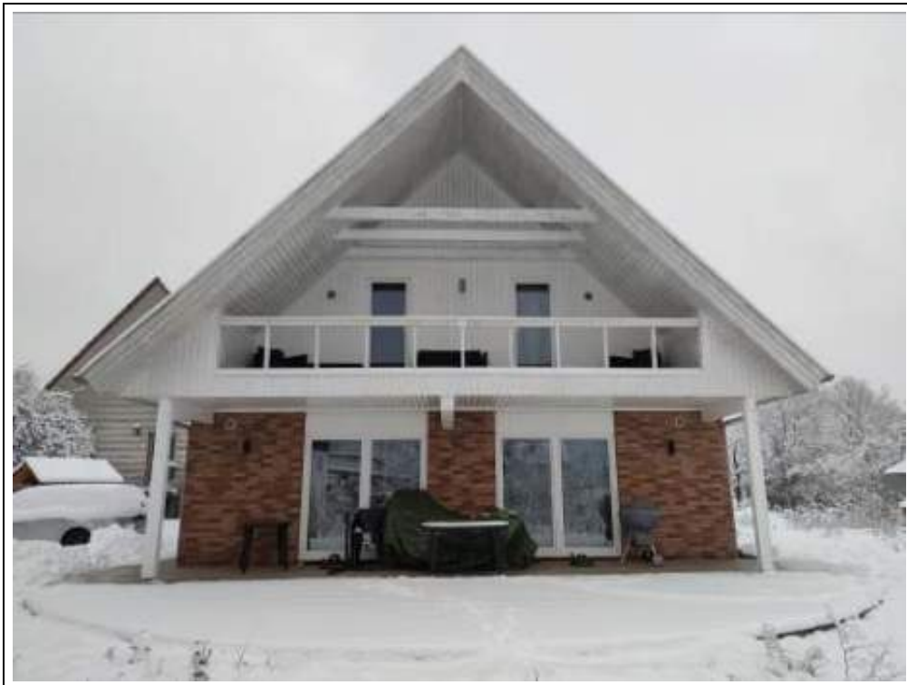
Blick auf das Bewertungsobjekt (Neubau) von Südwesten
