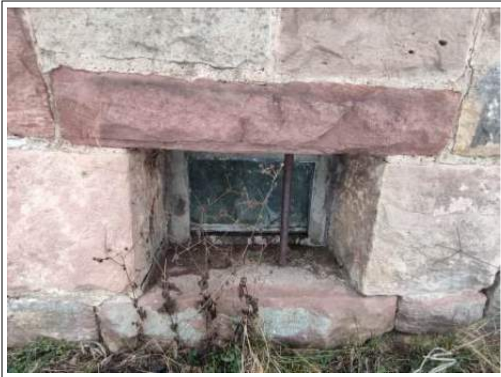
Blick auf das Kellermauerwerk und ein Kellerfenster
