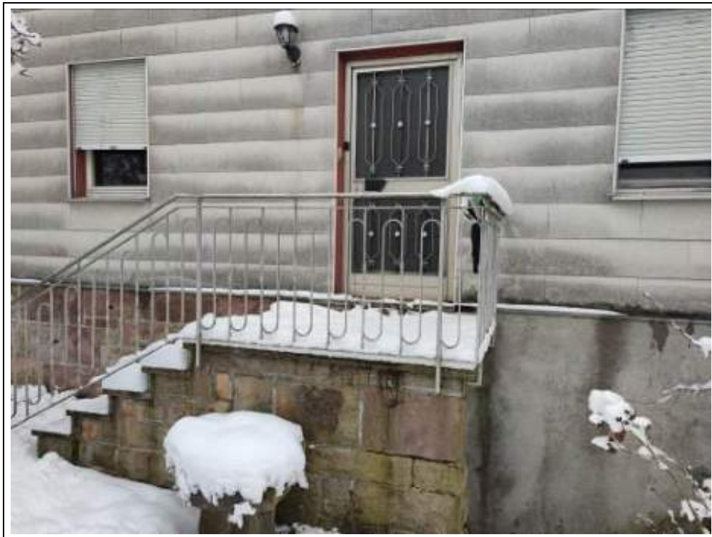
Blick auf den Hauseingangsbereich
