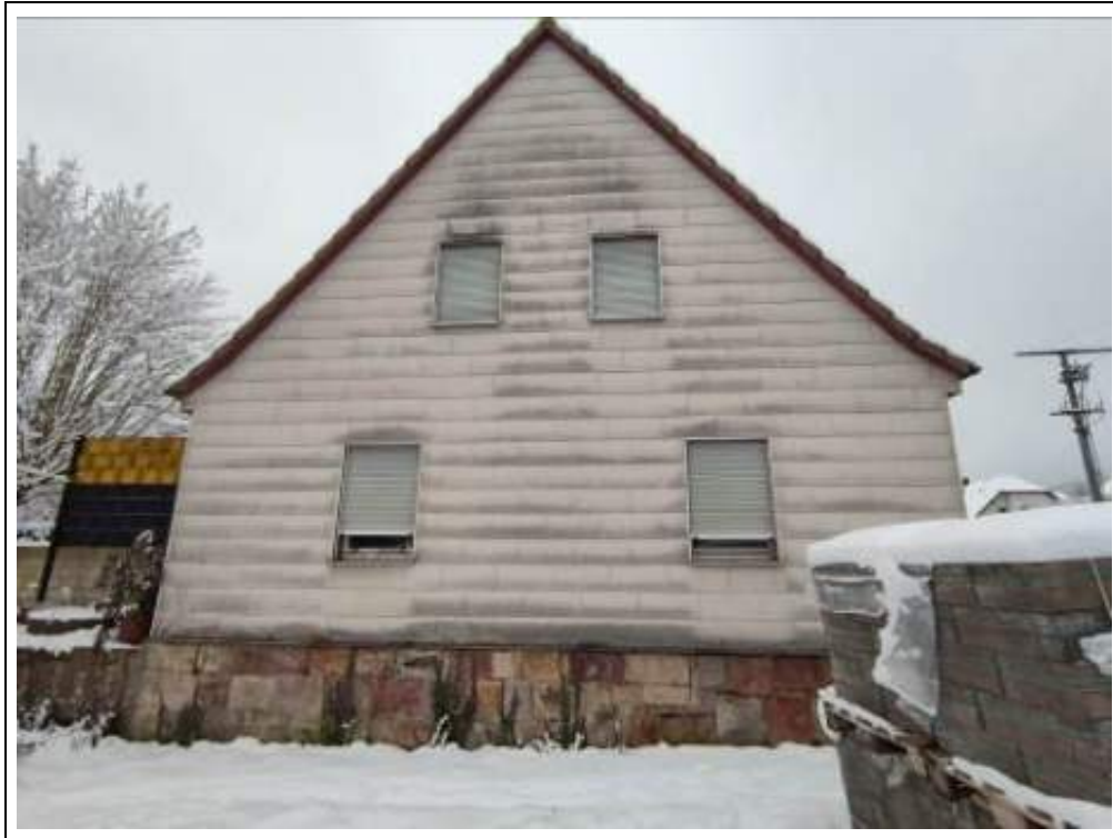
Blick auf das Bewertungsobjekt (Altbau) von Nordosten
