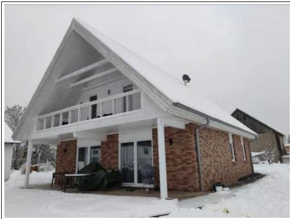
Blick auf das Bewertungsobjekt (Neubau) von Süden
