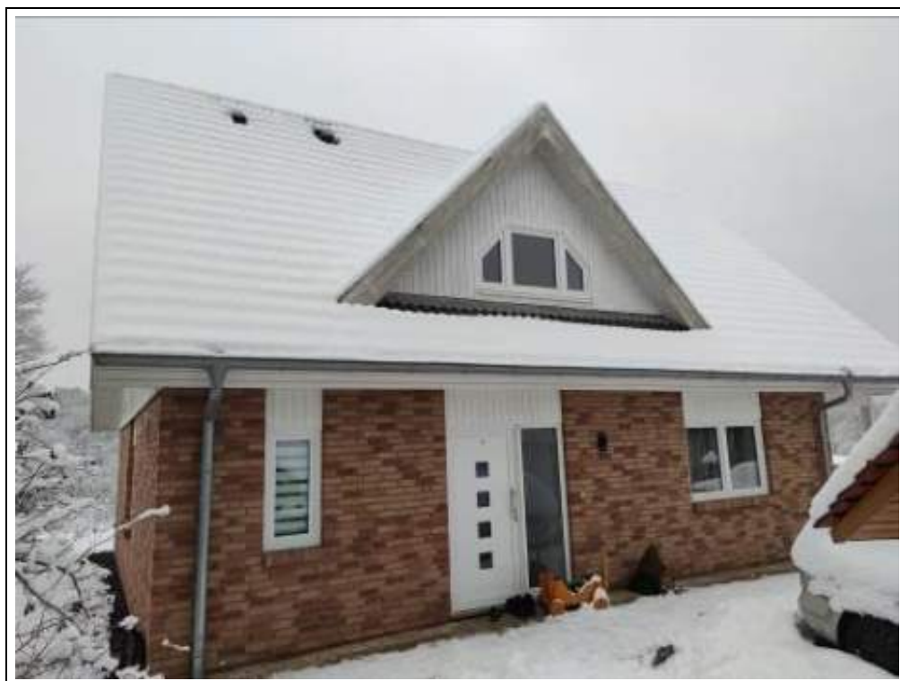
Blick auf das Bewertungsobjekt (Neubau) von Norden
