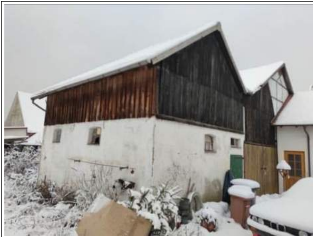
Blick auf den angebauten Stall und die Scheune von Osten
