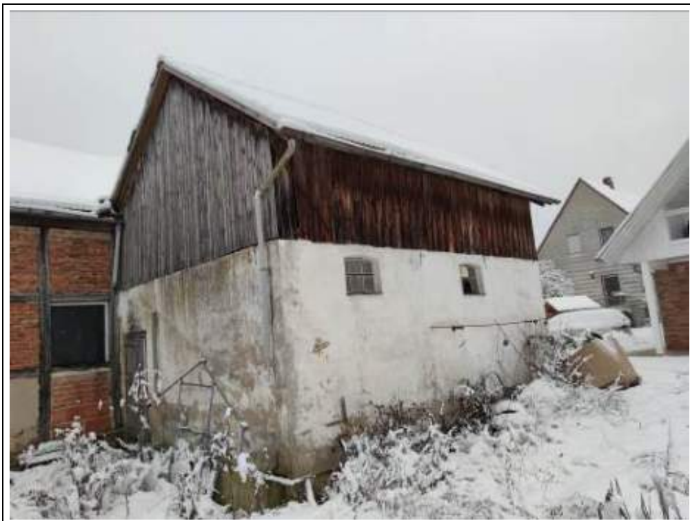
Blick auf den angebauten Stall von Süden
