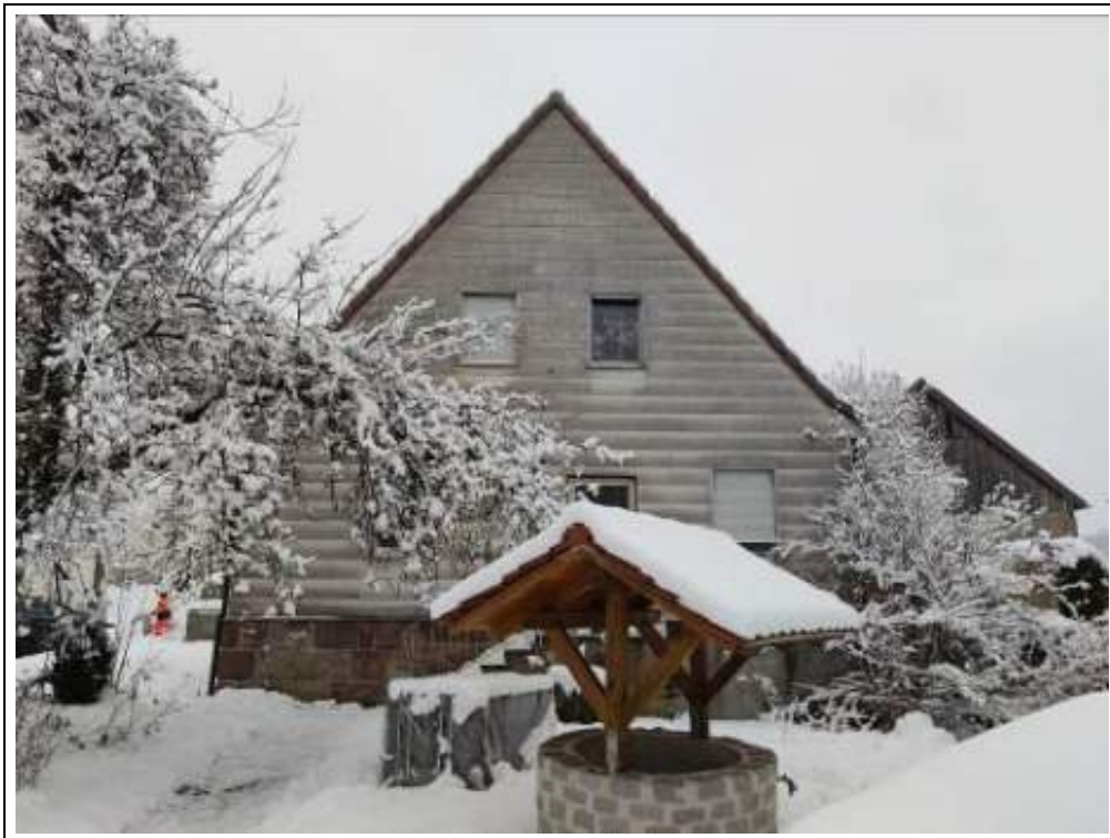
Blick auf das Bewertungsobjekt (Altbau) von Südwesten
