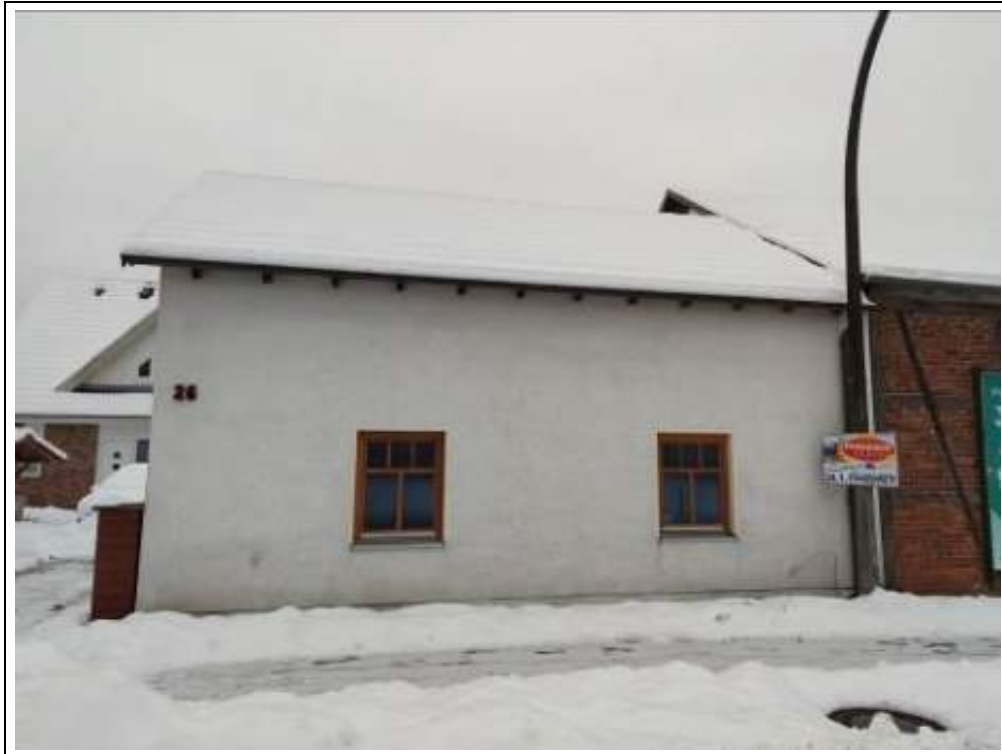
Blick auf die Garage von Nordwesten
