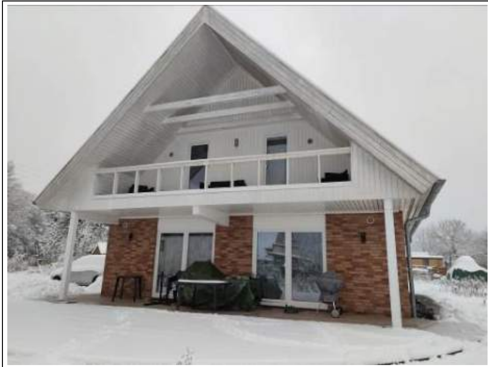
Blick auf das Bewertungsobjekt (Neubau) von Südwesten
