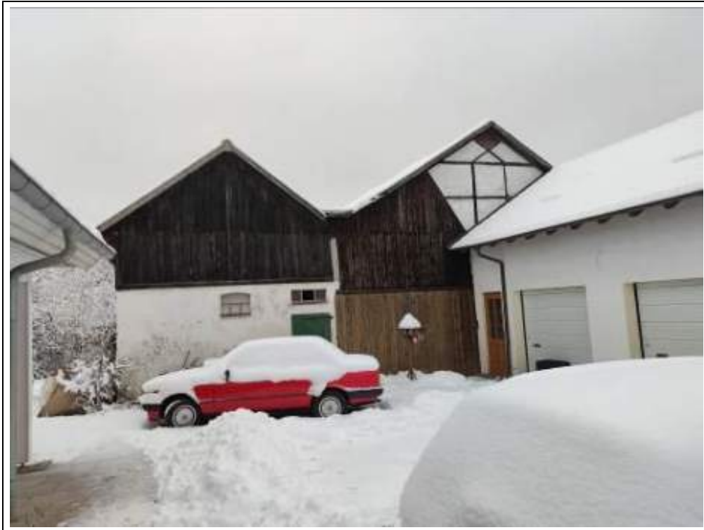
Blick auf den angebauten Stall, die Scheune und die Garage von Nordosten
