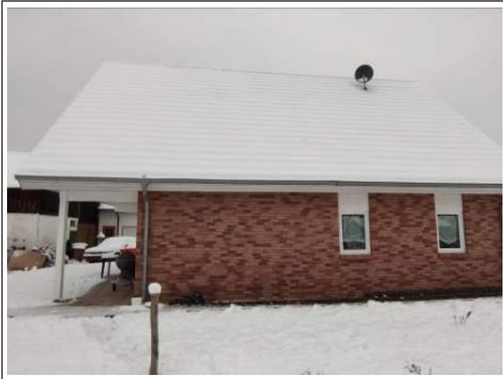
Blick auf das Bewertungsobjekt (Neubau) von Südosten
