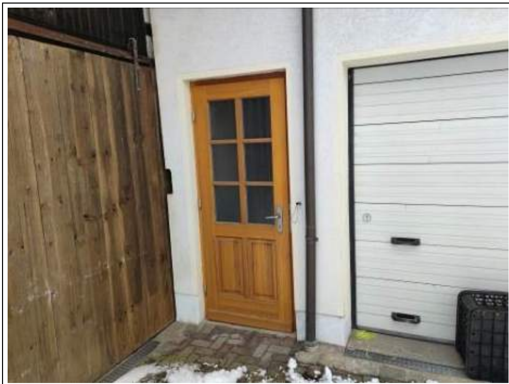
Blick auf die Nebeneingangstüre zur Garage
