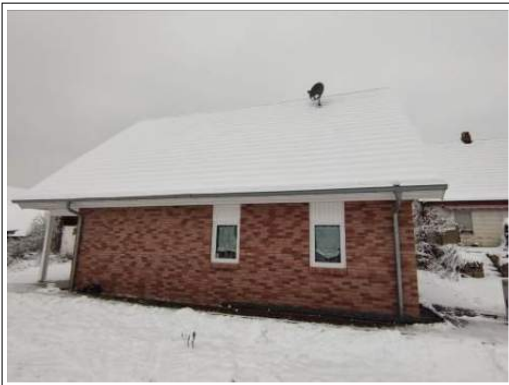
Blick auf das Bewertungsobjekt (Neubau) von Südosten
