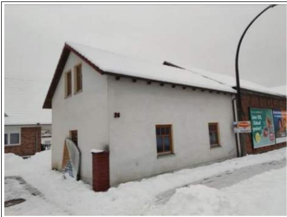
Blick auf die Garage von Norden
