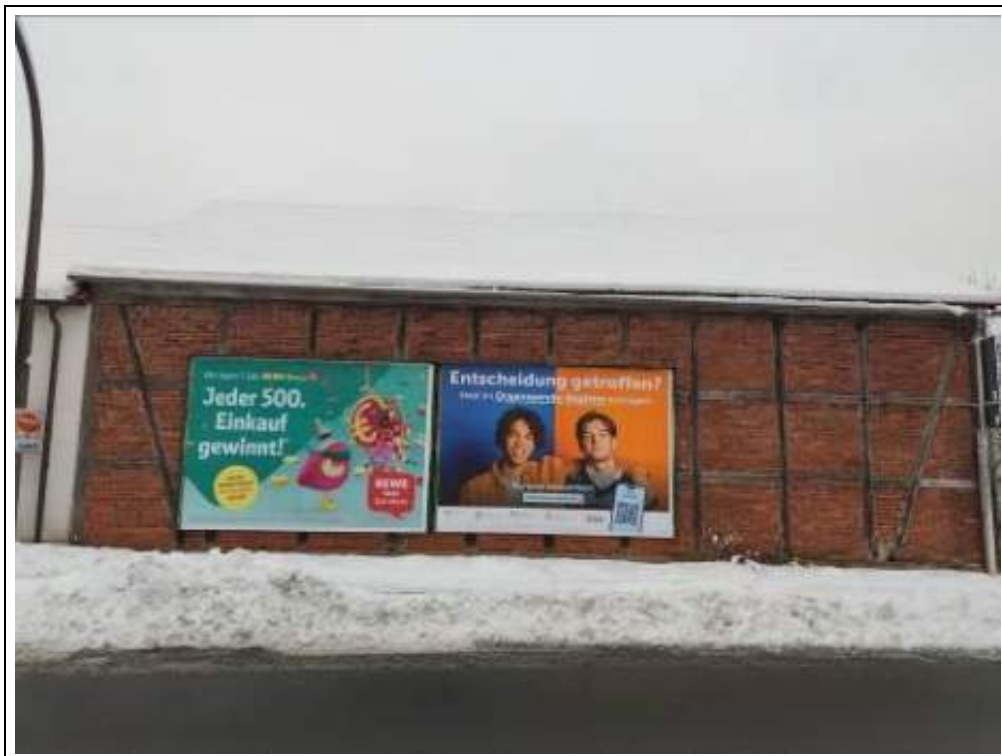
Blick auf die Scheune von Nordwesten
