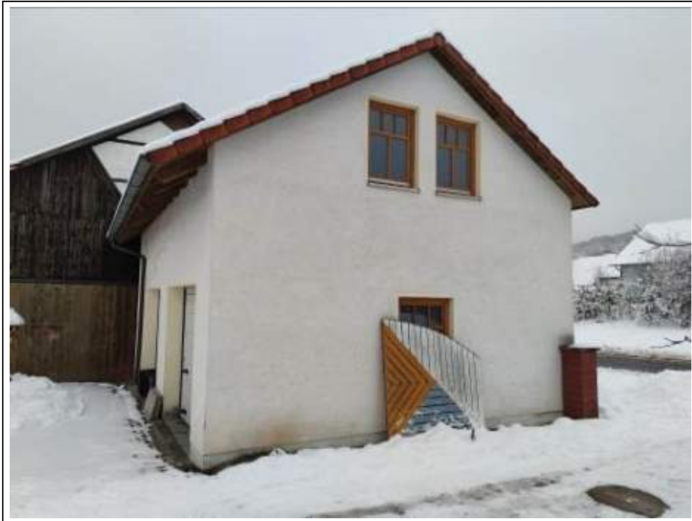
Blick auf die Scheune und die Garage von Nordosten
