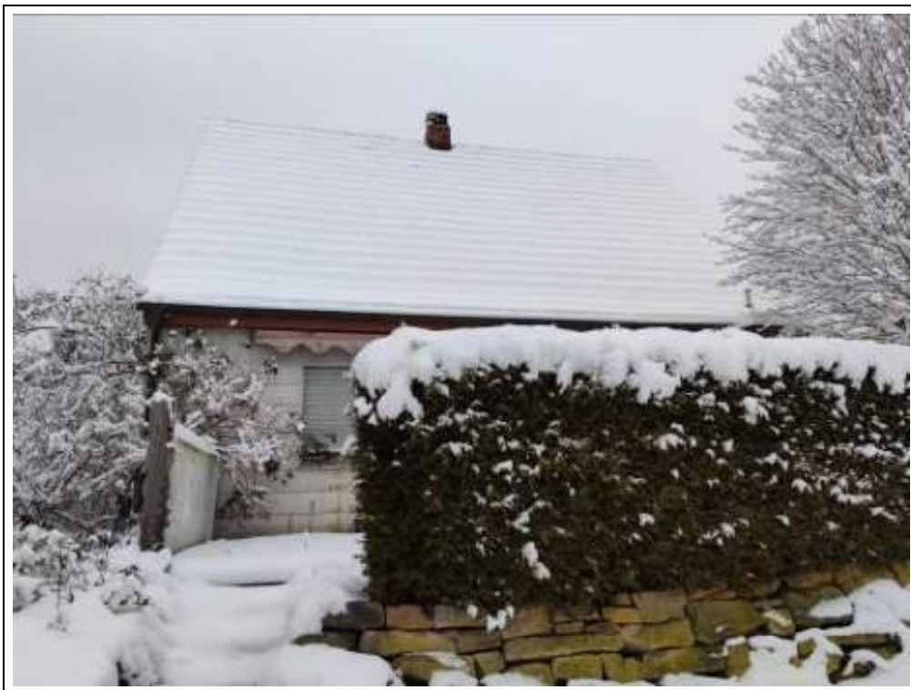
Blick auf das Bewertungsobjekt (Altbau) von Südosten
