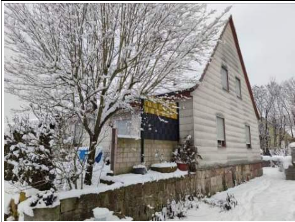
Blick auf das Bewertungsobjekt (Altbau) von Südosten
