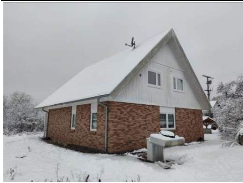
Blick auf das Bewertungsobjekt (Neubau) von Osten
