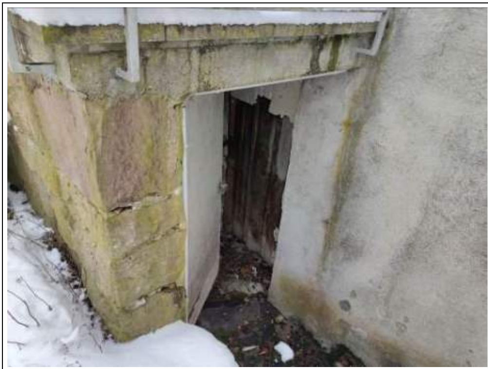
Blick auf den Zugang zum Keller
