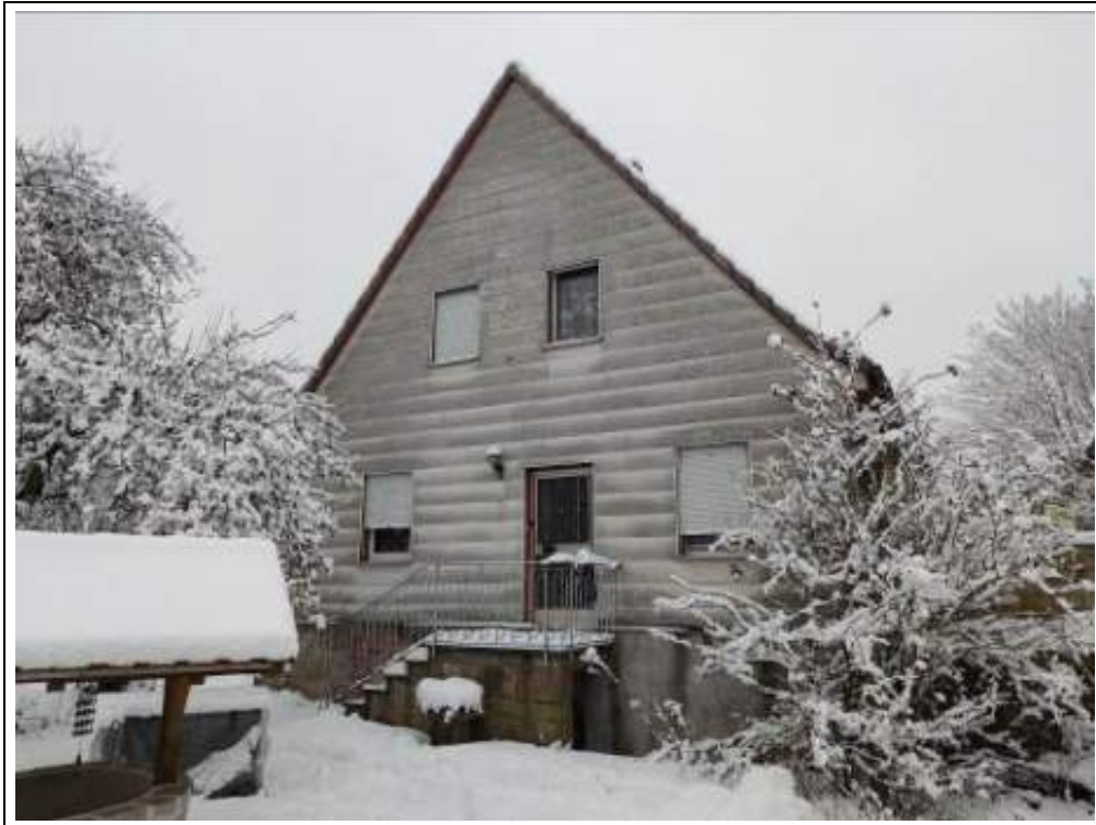
Blick auf das Bewertungsobjekt (Altbau) von Südwesten
