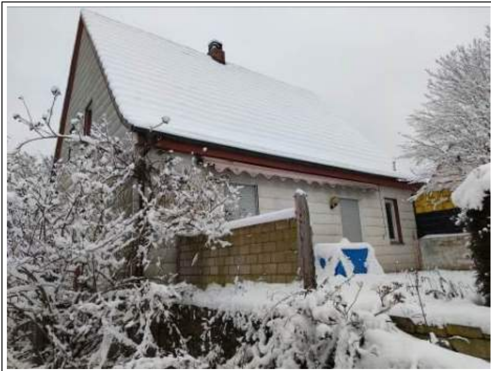
Blick auf das Bewertungsobjekt (Altbau) von Süden
