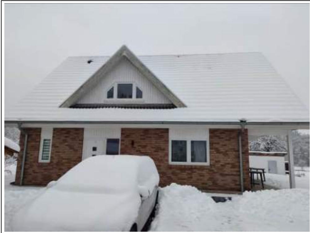
Blick auf das Bewertungsobjekt (Neubau) von Nordwesten
