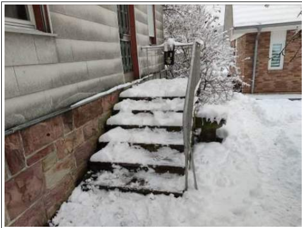
Blick auf die Hauseingangstreppe
