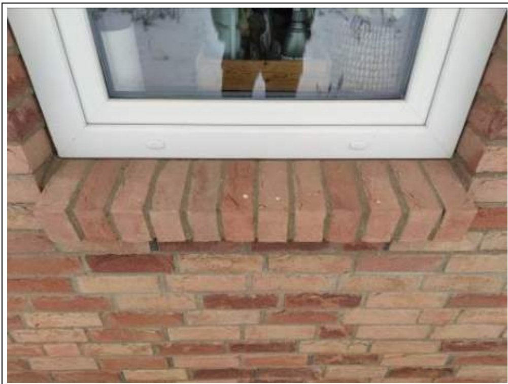
Blick auf die Klinkerverkleidung der Außenwand
