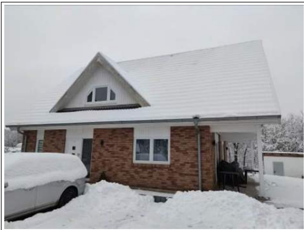
Blick auf das Bewertungsobjekt (Neubau) von Nordwesten
