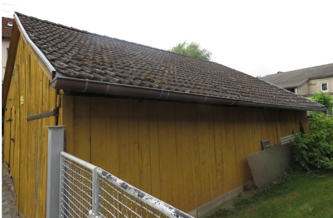
Abbildung: Ansicht von Nordosten
