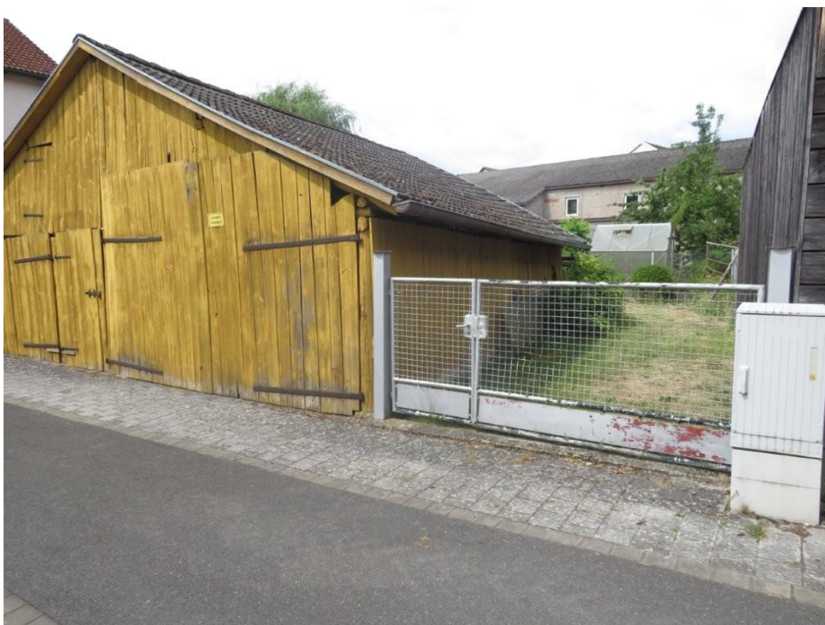
Abb.: Ansicht von Nordosten
