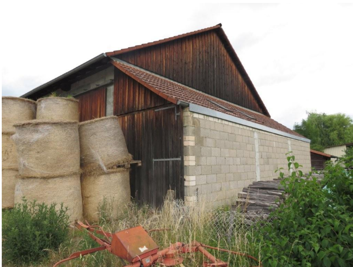
Abbildung: Ansicht von Südosten
