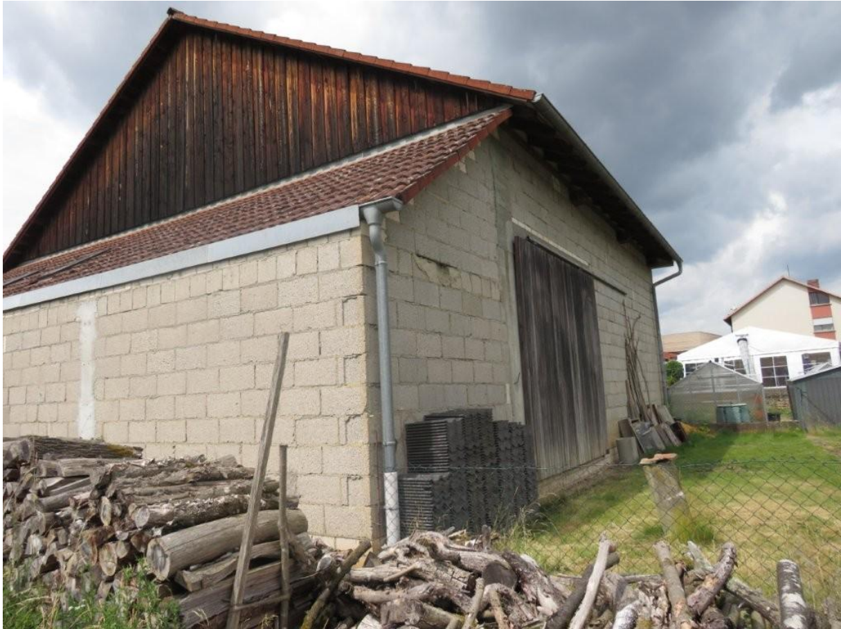
Abbildung: Ansicht von Nordosten
