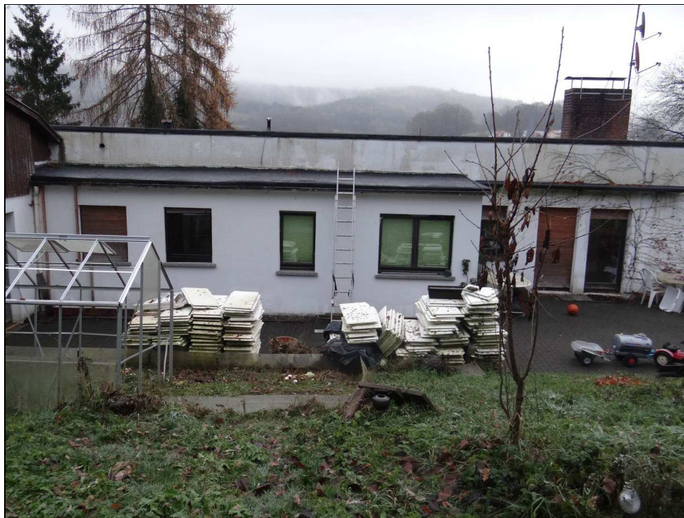
Bild 3: Süd-West-Ansicht des Wohngebäudes
