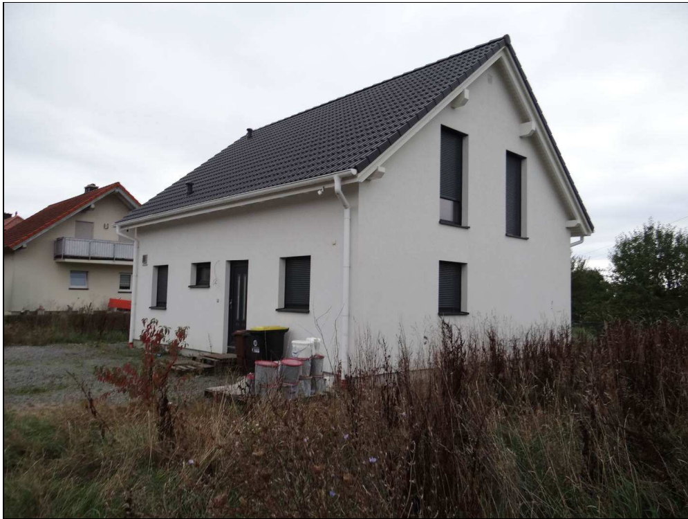
Bild 1: Blick auf das Anwesen von Norden
