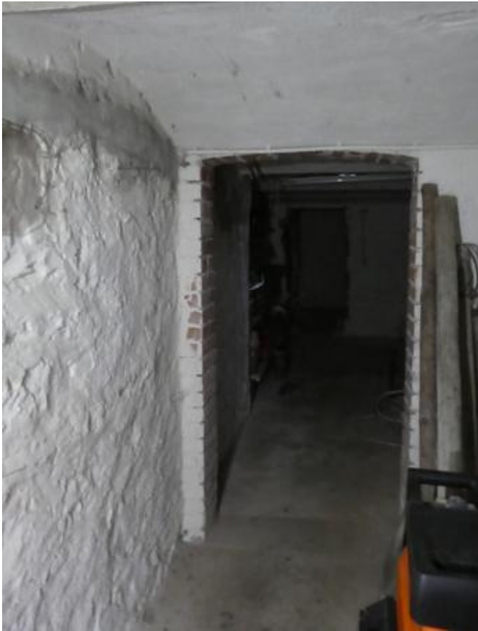
Durchgang im Bereich Wohnhausunterkellerung.
