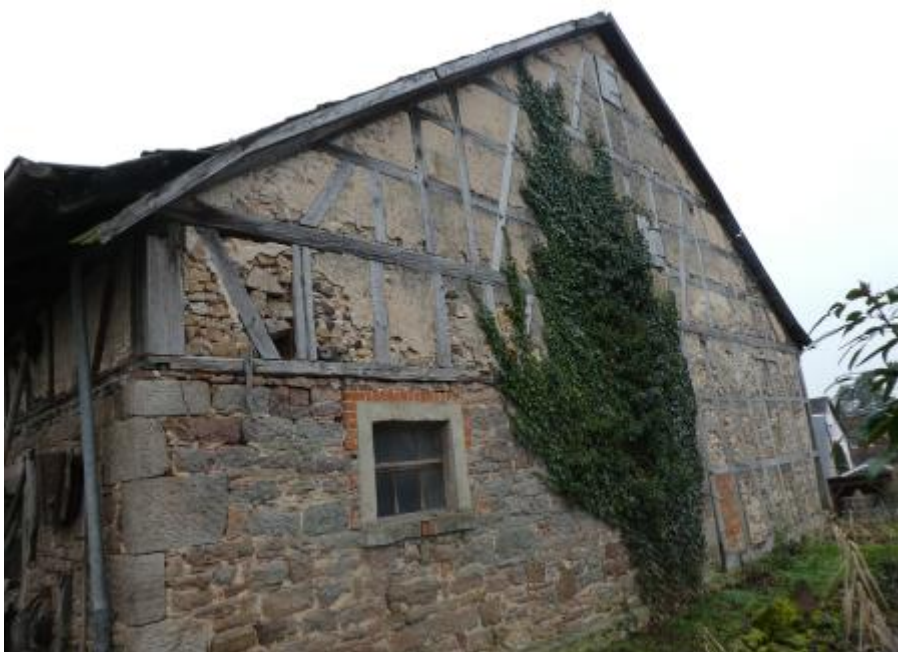
Scheune i Ansicht Nord.
