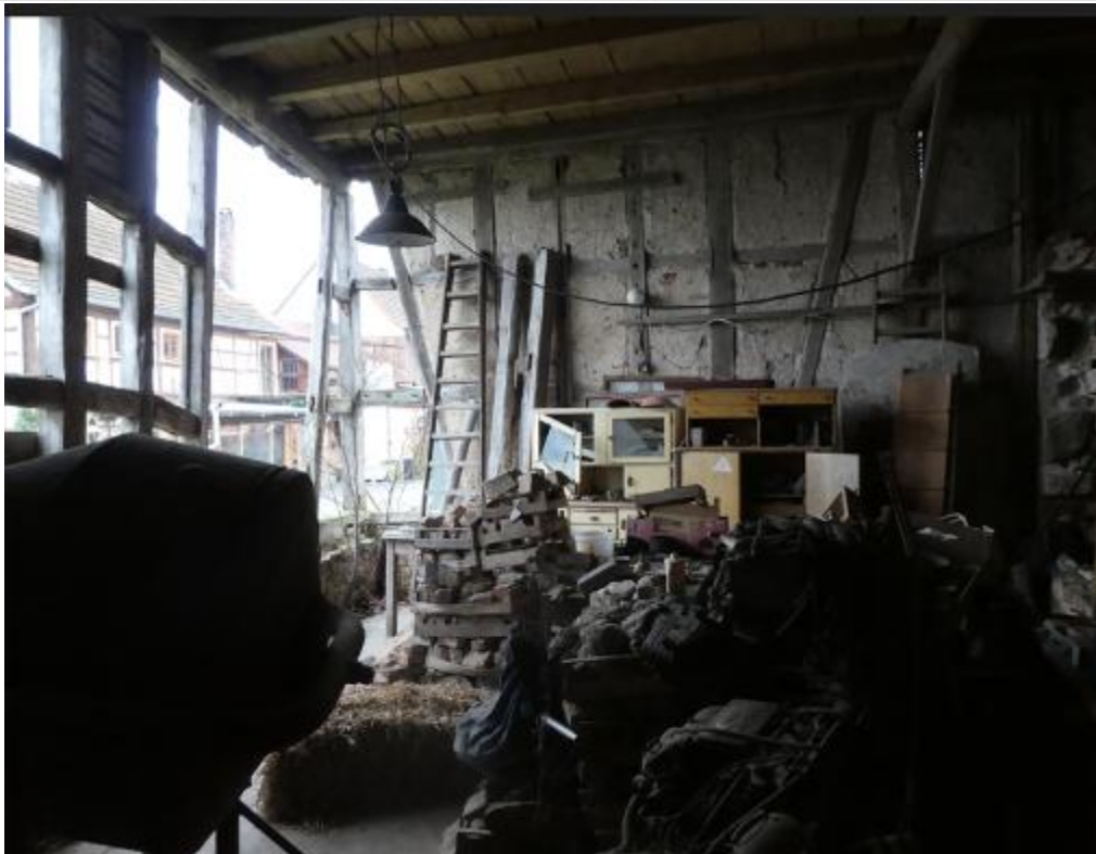
Scheune i Innenansicht.
