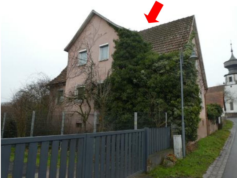
Wohnhaus i Ansicht Süd-/Ost mit Grundstückszufahrt von der Ostseite über die Braidbacherstraße in 97654 Bastheim/OT Reyersbach.
