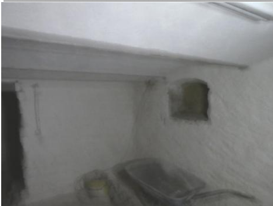
Blick in den Keller (Fenster u. Kappendecke).
