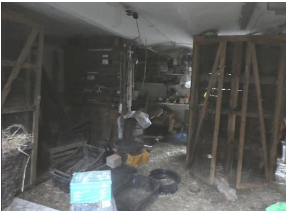
Blick in ehemaliges Stallungsgebäude mit Kappendecke.
