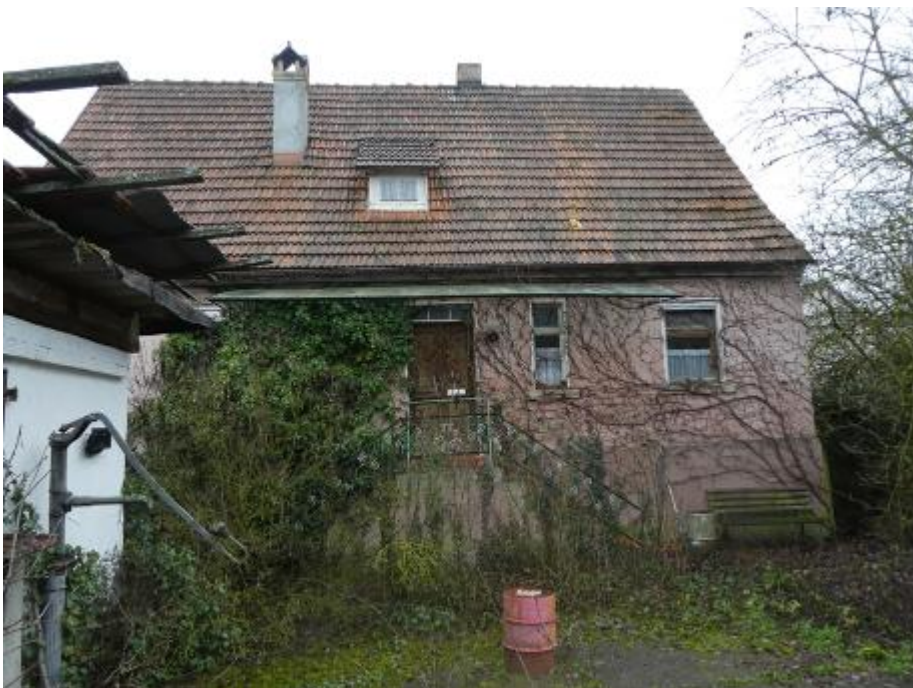
Wohnhaus i Ansicht Nord-/West mit Blick vom Innenhof auf den Hauseingang.
