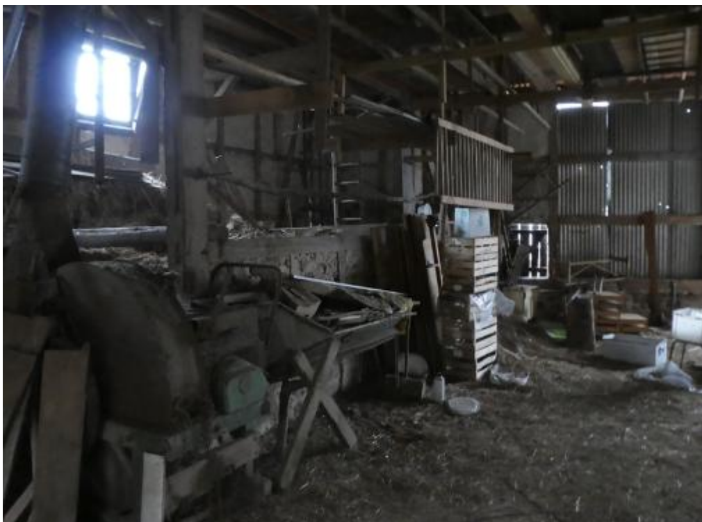
Scheune i Innenansicht.
