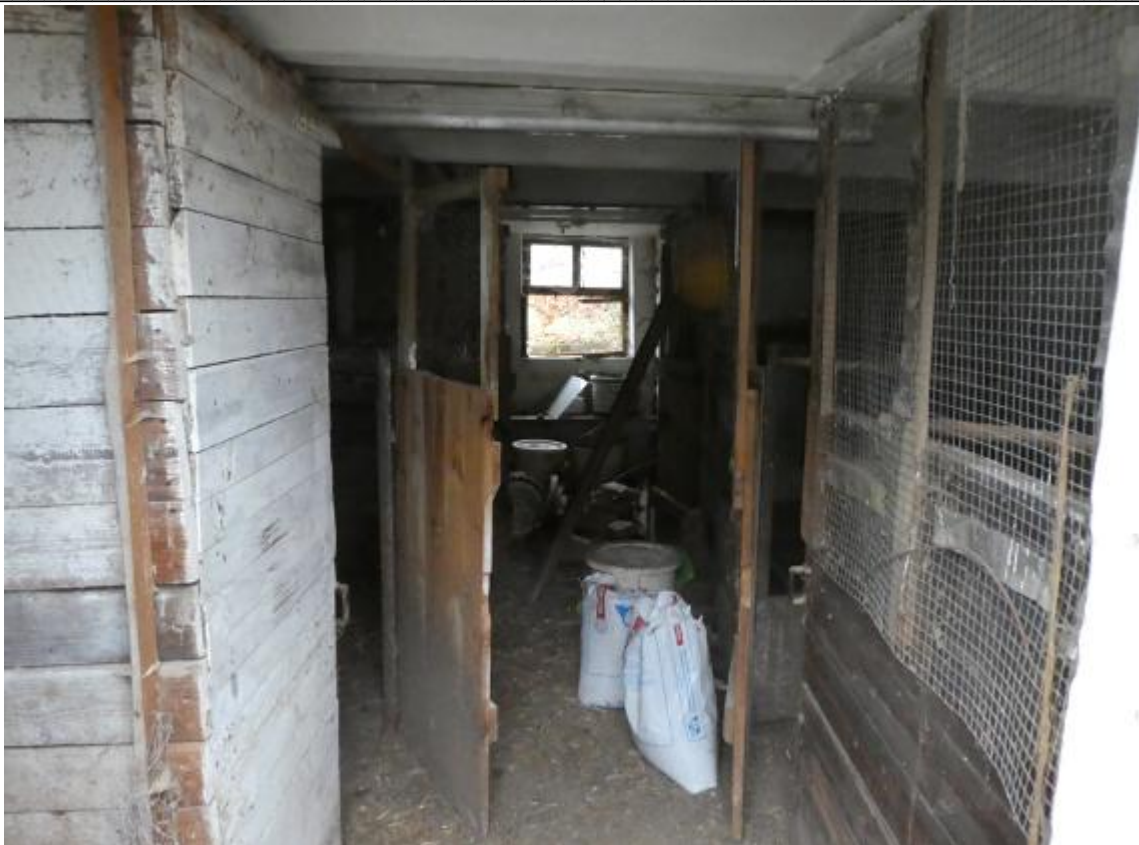
Blick in das ehemalige Stallungsgebäude.
