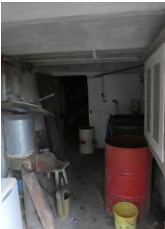
Kappendecke im Bereich Wohnhausunterkellerung.
