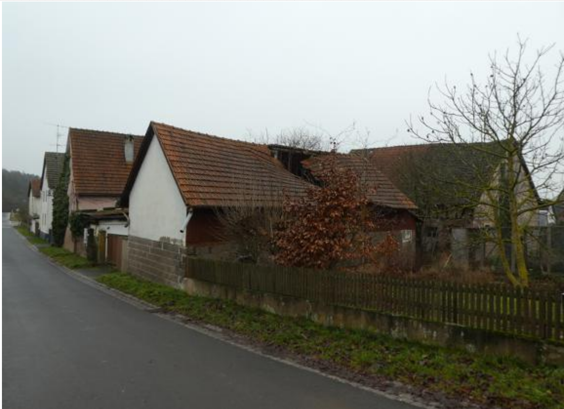
Ansicht Nord i mit Blick auf ehemalige Stallung und Scheune.
