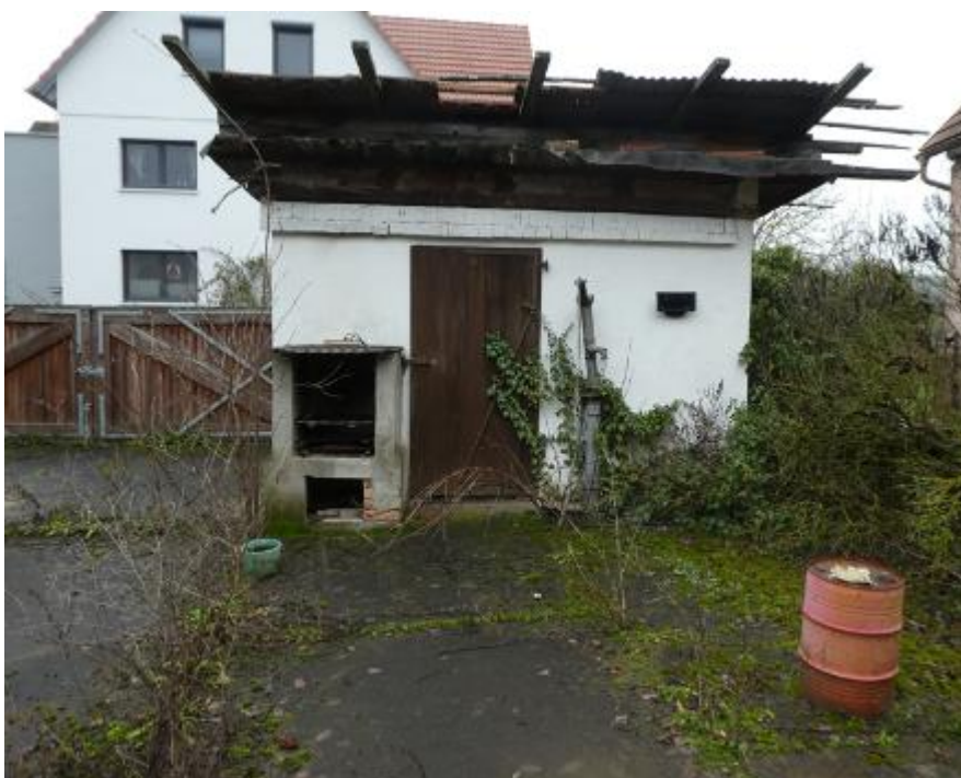
Nebengebäude (den Außenanlagen zugerechnet) i Ansicht West.
