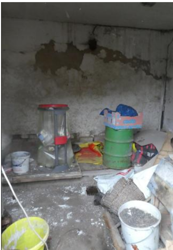
Blick in Nebengebäude.
