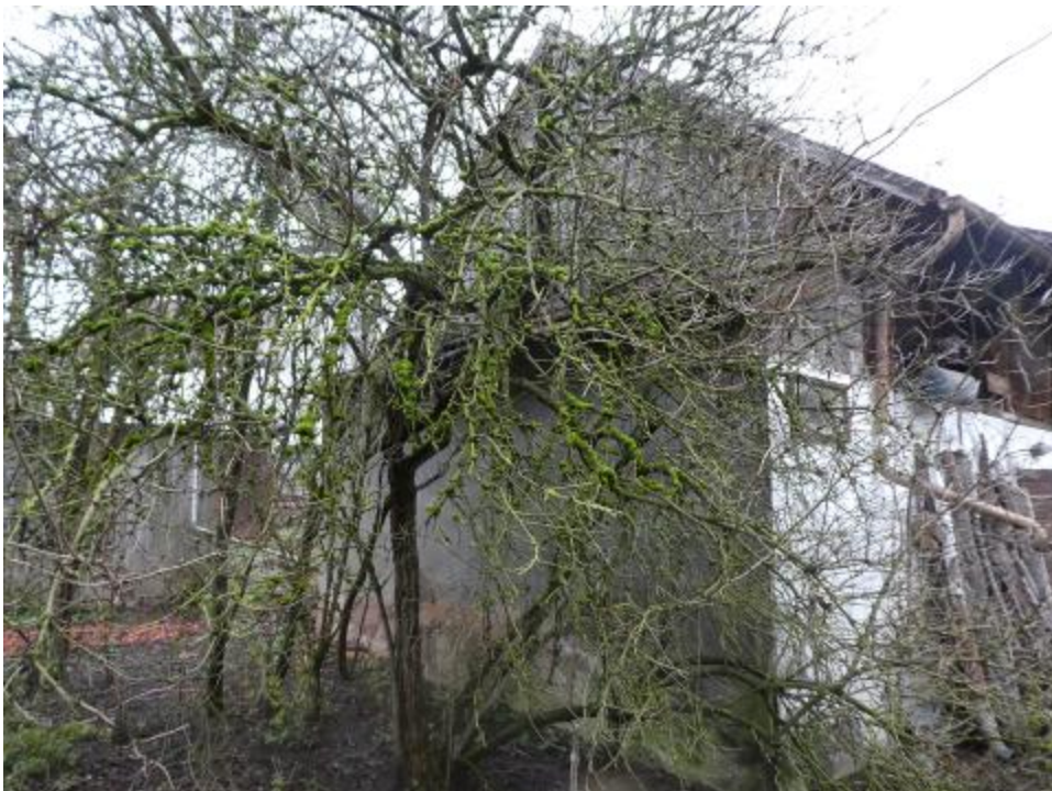
Ehemalige Stallung i Ansicht West.
