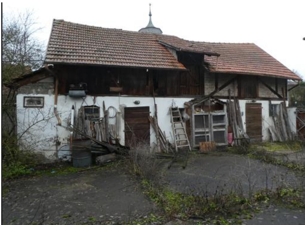
Ehemalige Stallung i Ansicht Süd i vom Innenhof.
