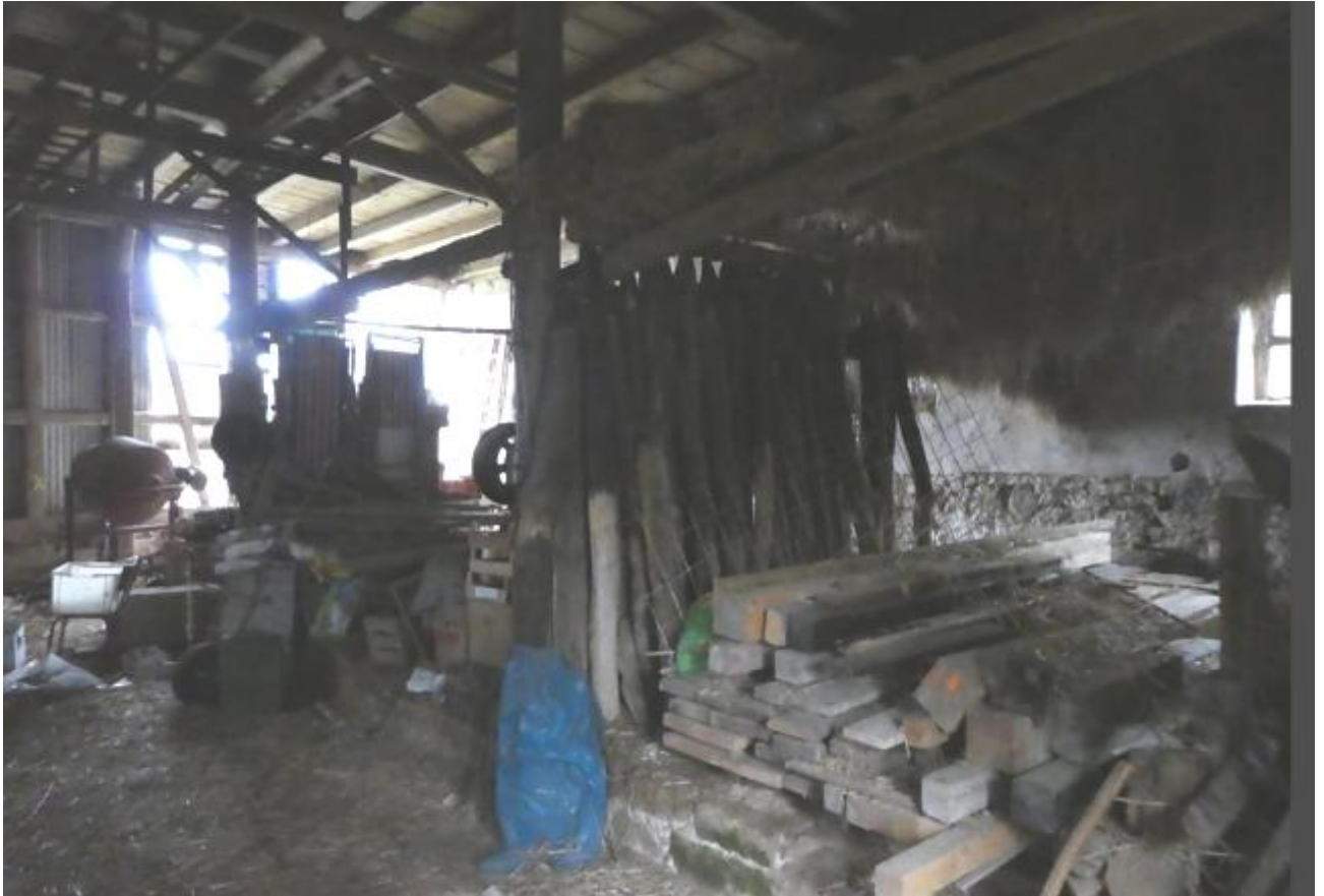
Scheune i Innenansicht.
