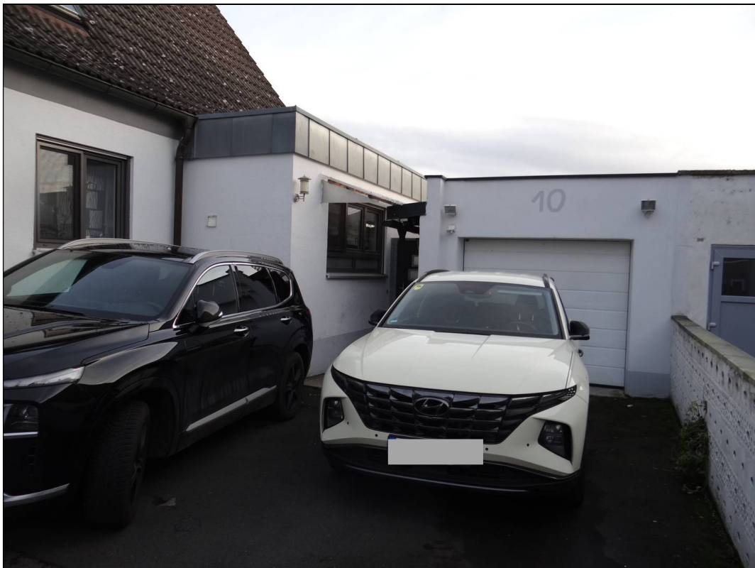
Bild 2: Nord-West-Ansicht der Garage
