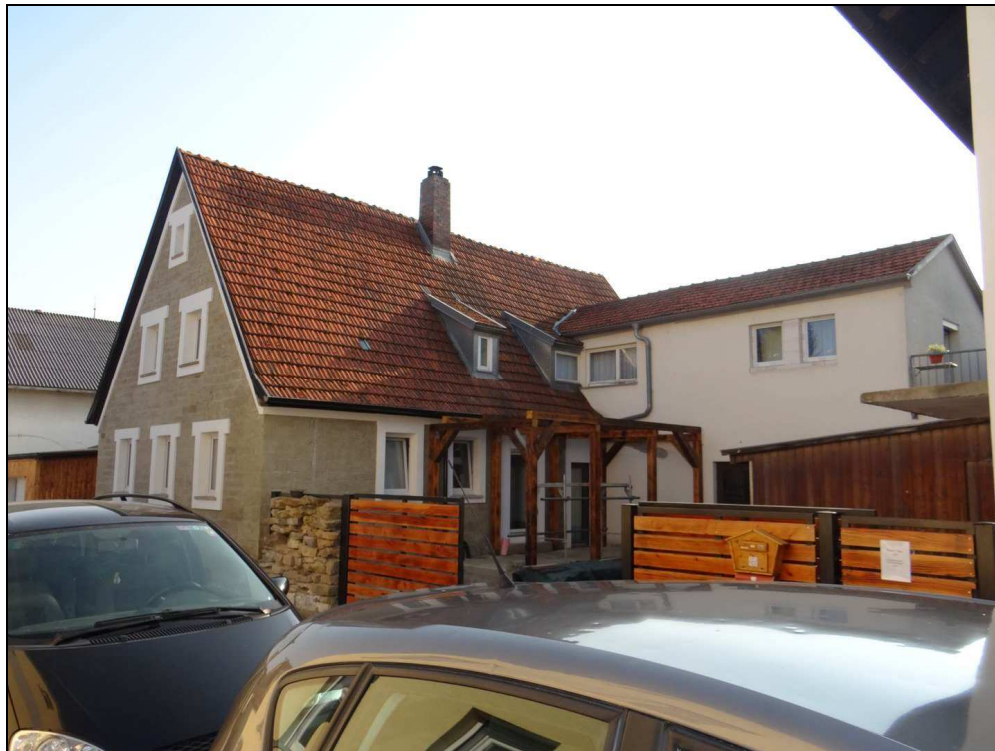
Bild 2: Nord-Ansicht Wohn- und Geschäftsgebäude (A)
