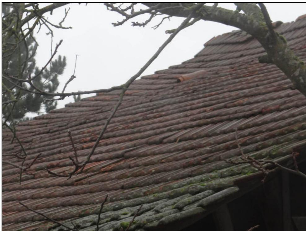
Bild 42: schadhafte Dacheindeckung, Scheunengebäude
