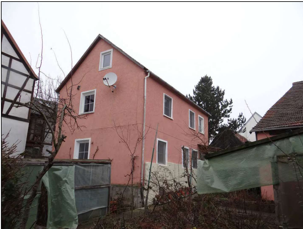
Bild 2: Blick auf das Wohngebäude II von Süden
