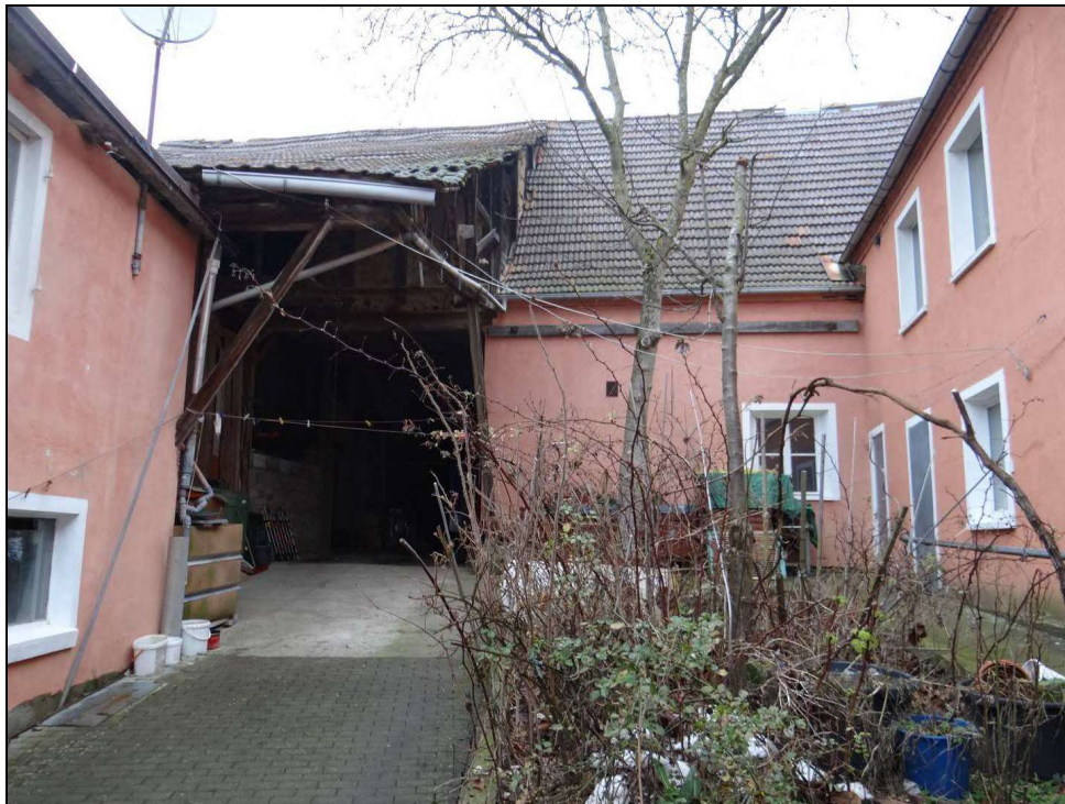
Bild 4: Süd-West-Ansicht der östlichen Freifläche und des Scheunengebäudes
