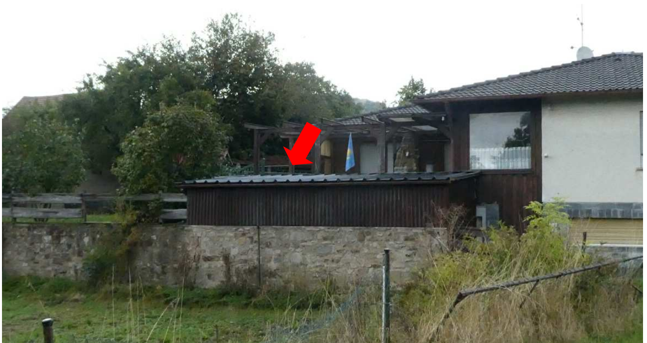
Ansicht Süd-Detail Nebengebäude mit Trapezblecheindeckung.
