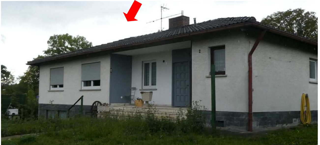
Ansicht Nord-/Ost (Gartenansicht) mit Hauseingang auf Seite Ost.
