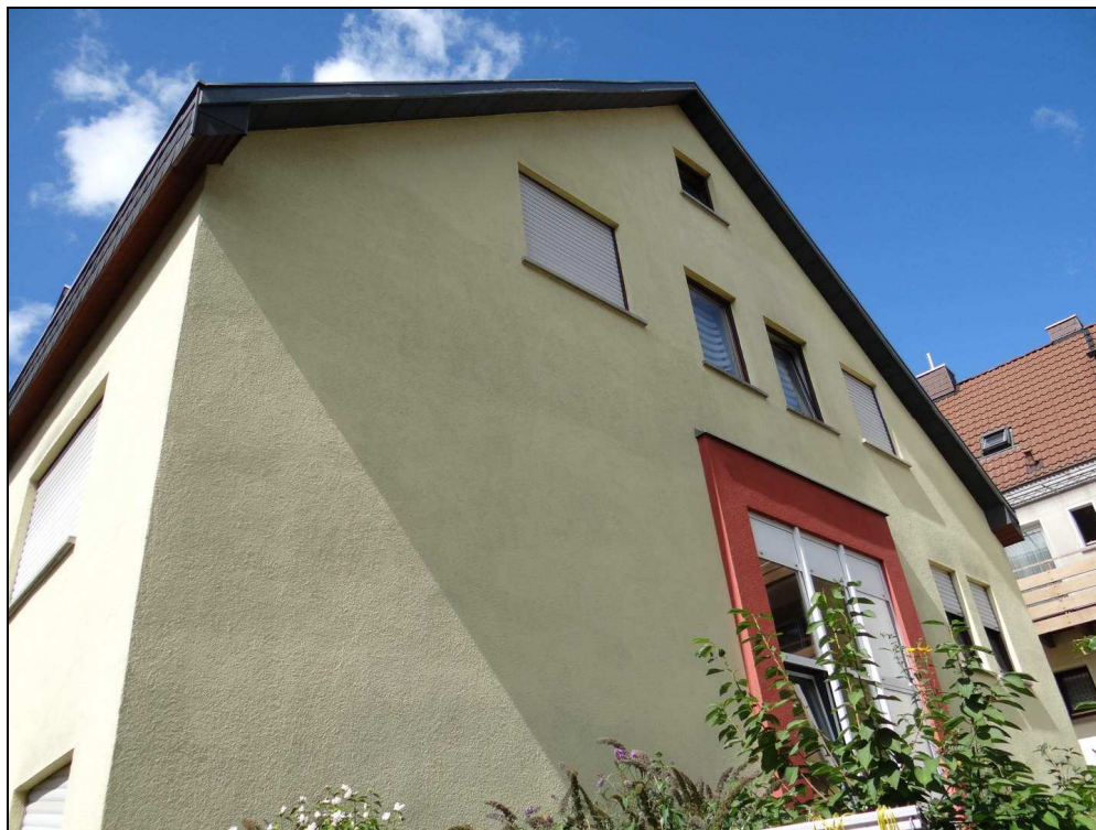
Bild 4: Ost-Fassade des Wohngebäudes
