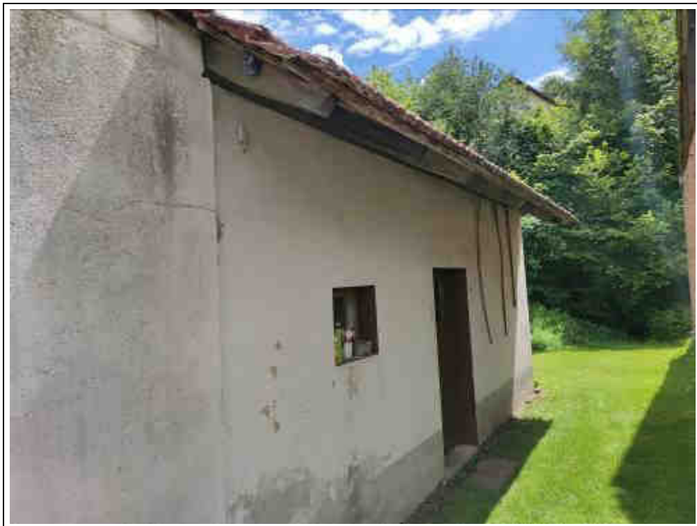
Blick auf das Nebengebäude von Norden (Teilansicht)
