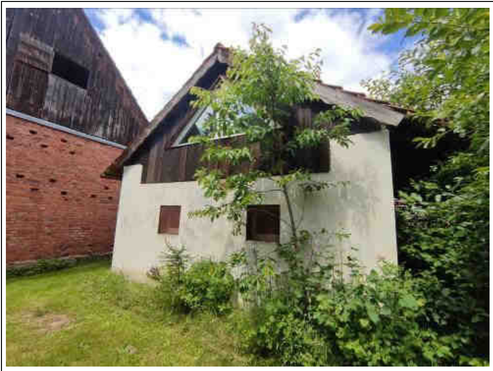
Blick auf das Nebengebäude von Süden
