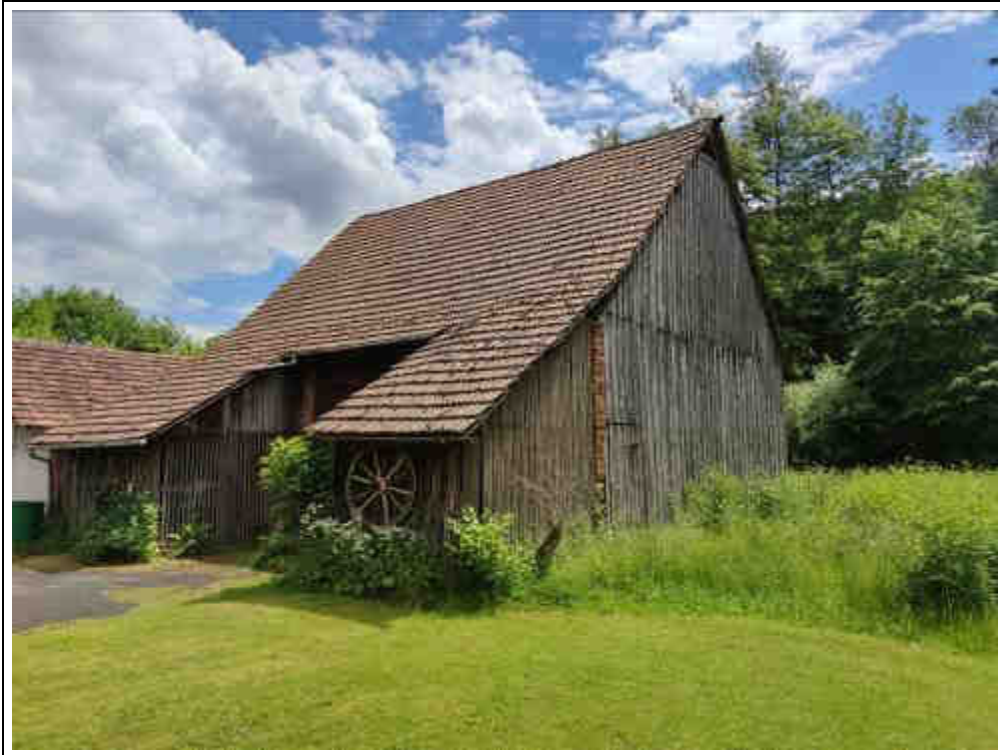
Blick auf die Scheune von Nordwesten
