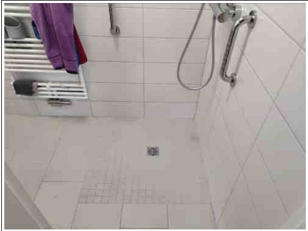
Blick in die Dusche im Erdgeschoss
