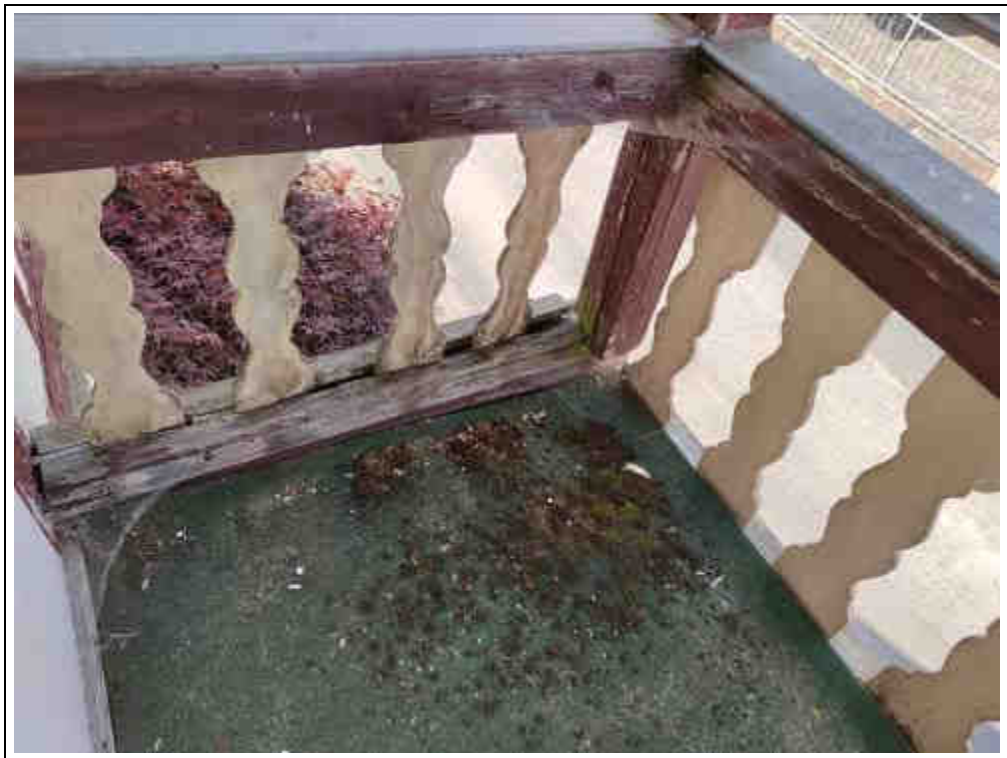
Blick auf den Balkon bei der Eingangsüberdachung
