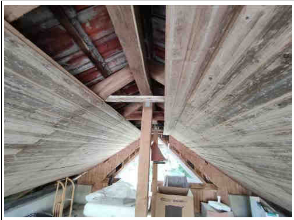
Blick gegen die Dachkonstruktion im Bereich des Nebengebäudes
