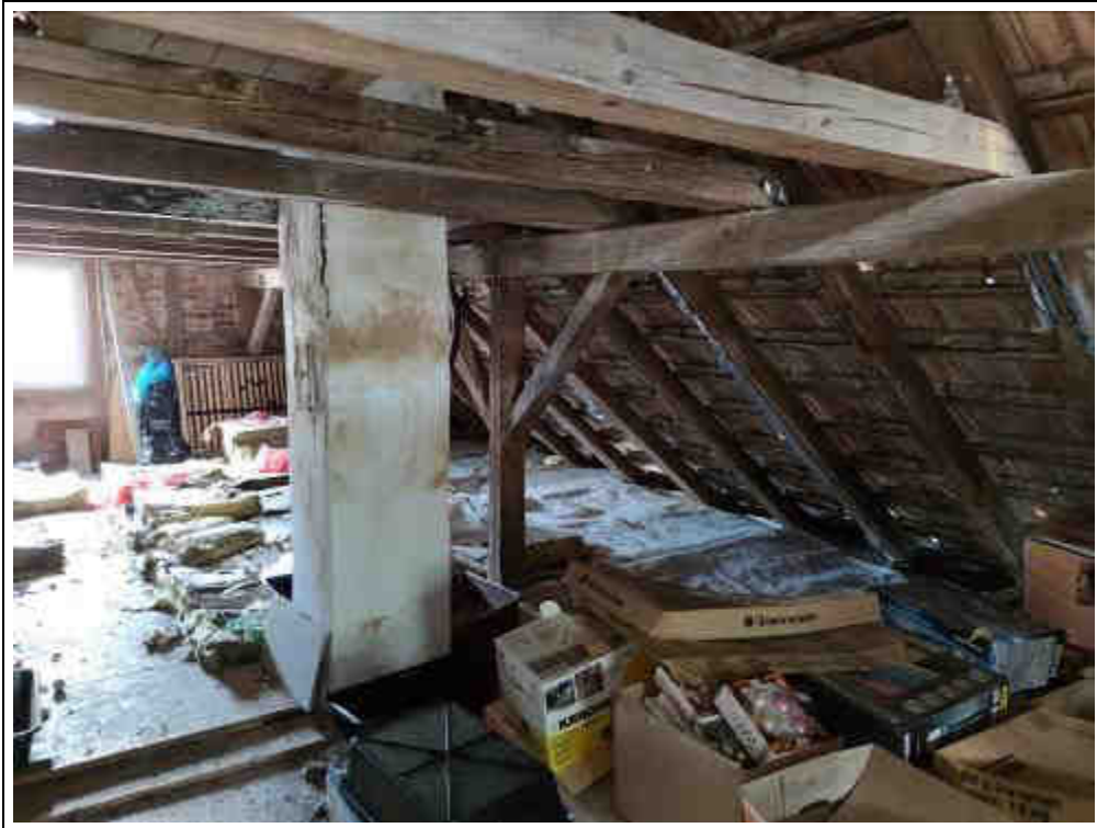
Blick in das Dachgeschoss
