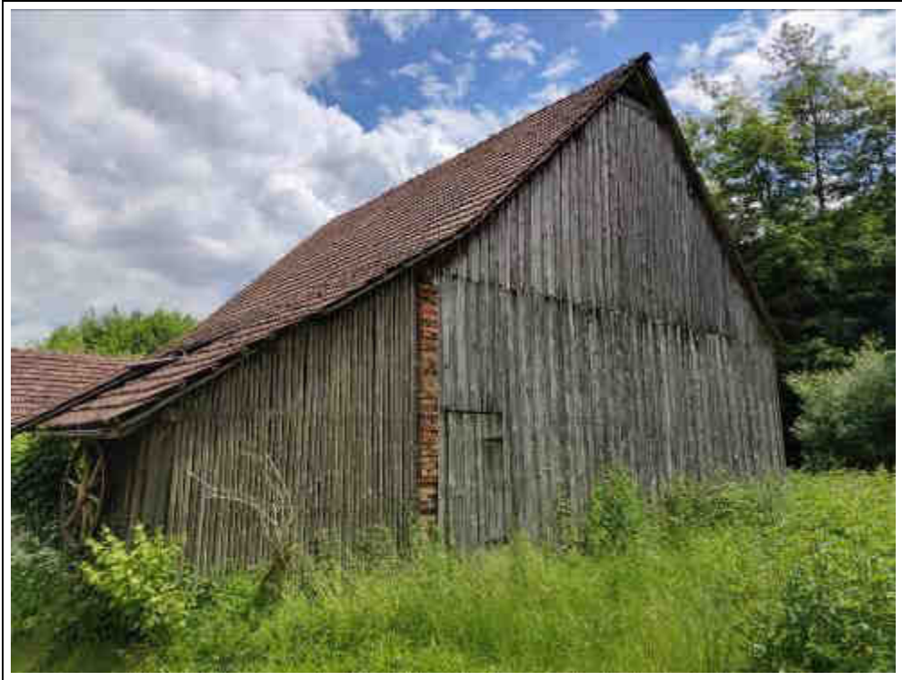
Blick auf die Scheune von Nordwesten
