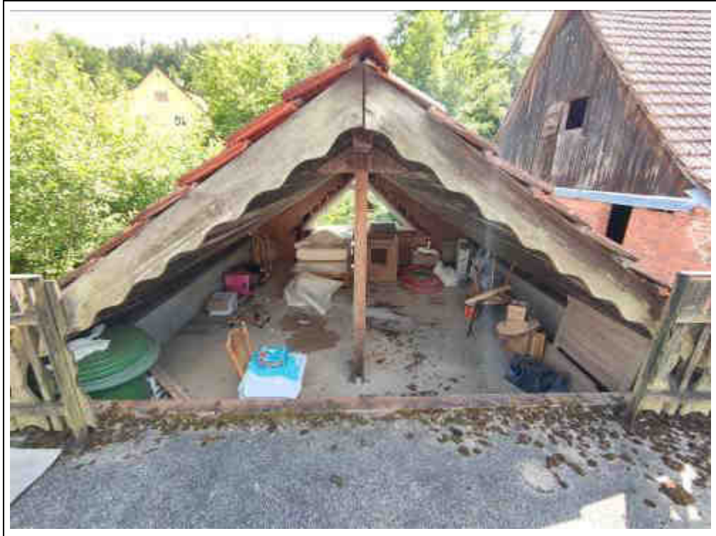
Blick in das Dachgeschoss des Nebengebäudes vom Balkon über der Garage
