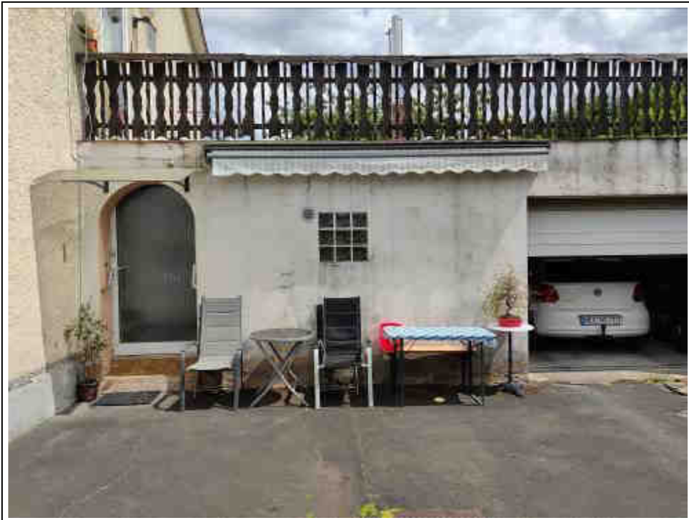
Blick auf die Garage und den Eingang zum Zwischenflur von Westen
