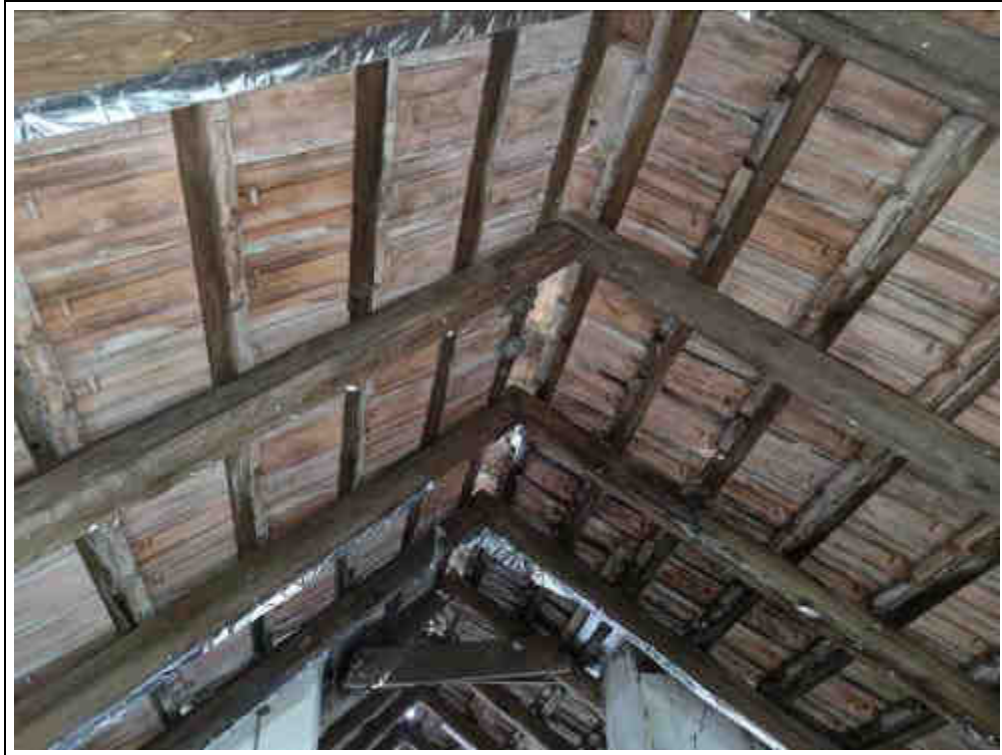
Blick in das Dachgeschoss - Dachgeschoss
