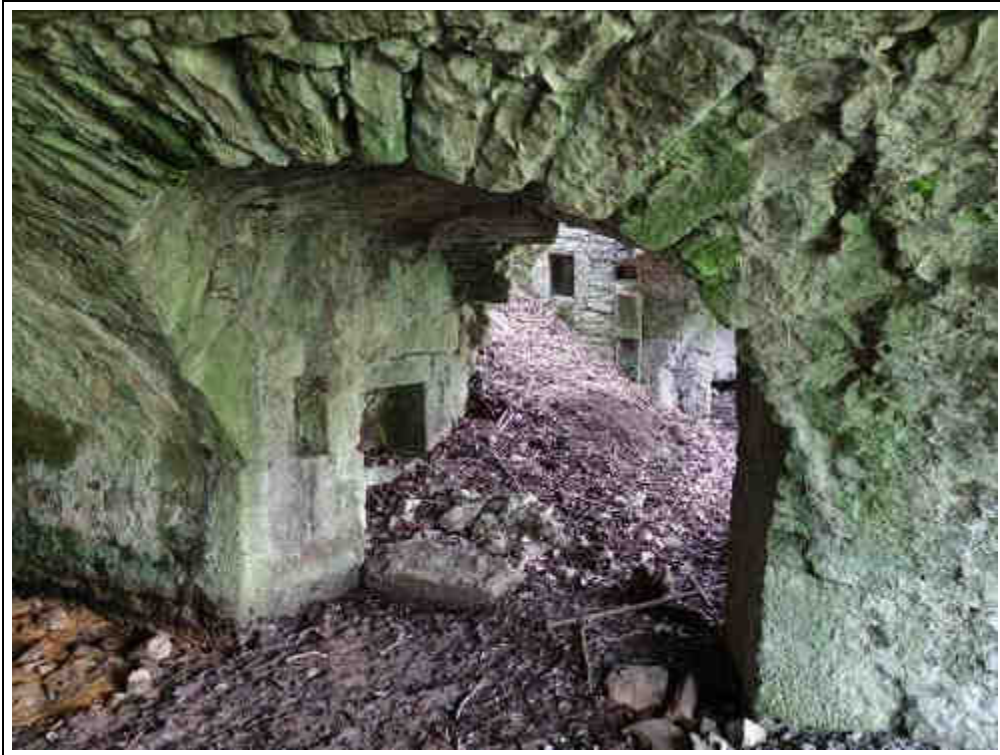
Blick in den Gewölbekeller
