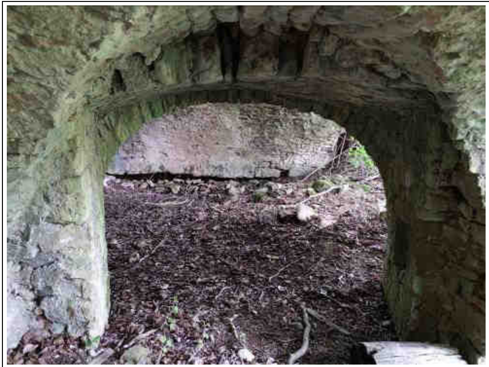
Blick in den Gewölbekeller
