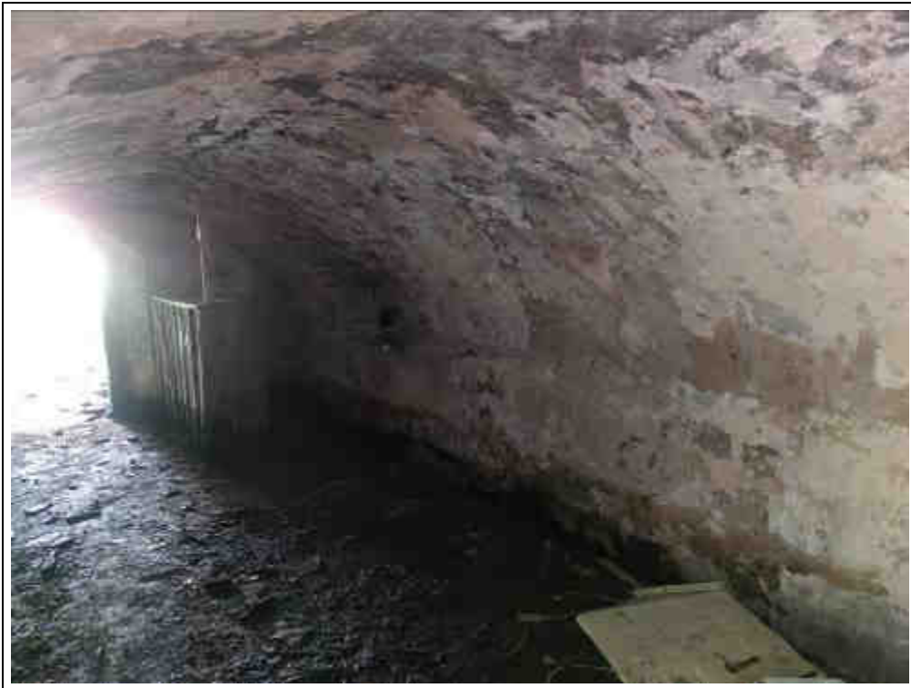
Blick in den Gewölbekeller
