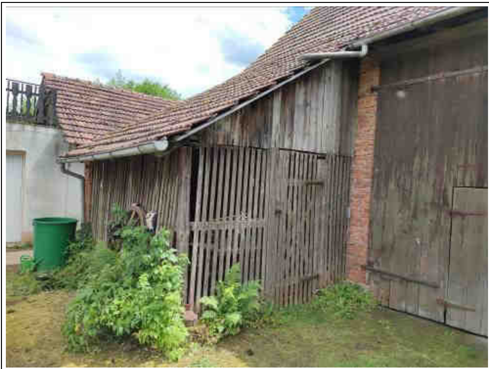
Blick auf einen Scheunenanbau
