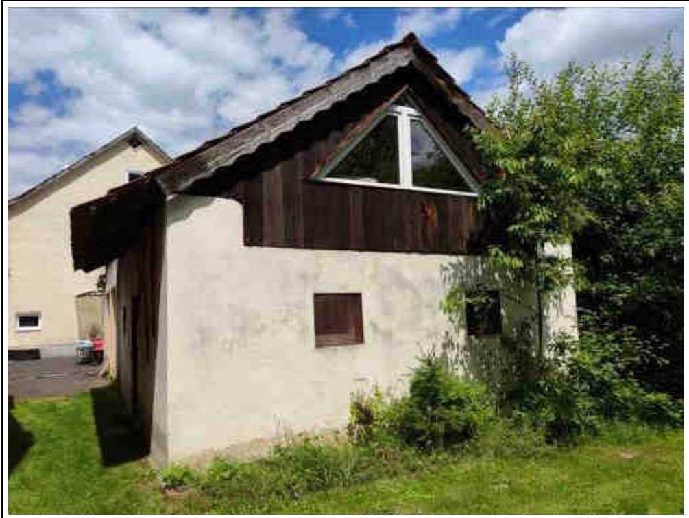
Blick auf das Nebengebäude von Süden
