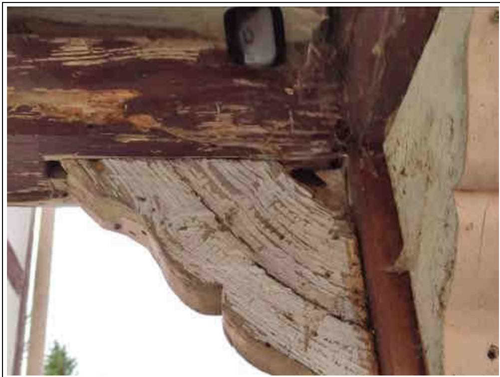
Blick auf den Zustand der Holzkonstruktion im Bereich des Balkons / Eingangüberdachung
