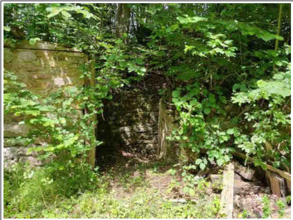
Blick auf einen Zugang zum Gewölbekeller
