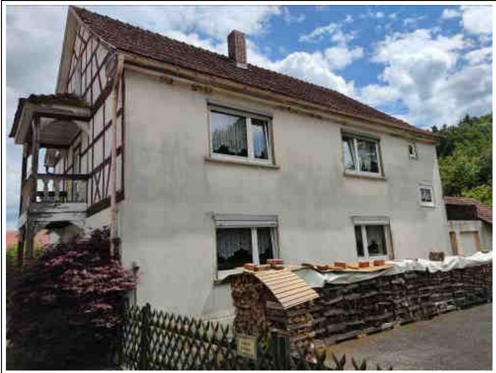
Blick auf das Wohnhaus von Nordwesten
