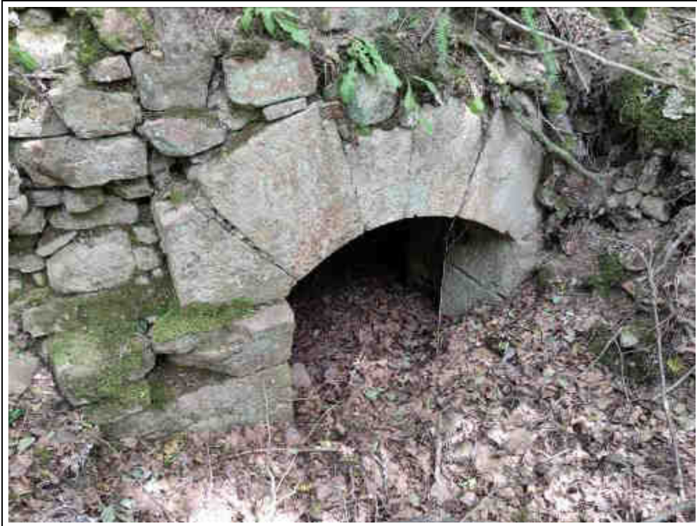
Blick in den Gewölbekeller
