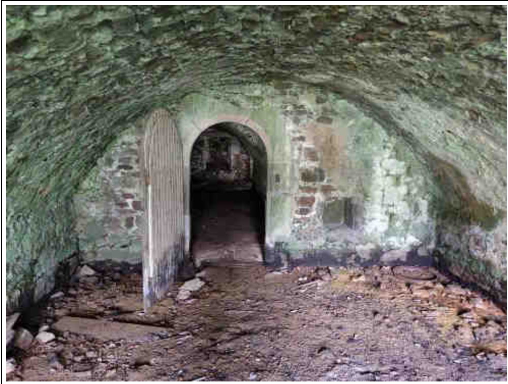
Blick in den Gewölbekeller
