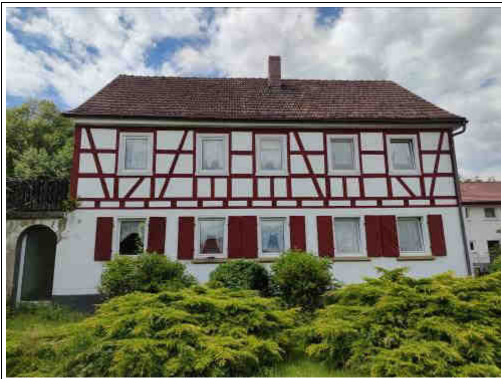
Blick auf das Wohnhaus von Osten
