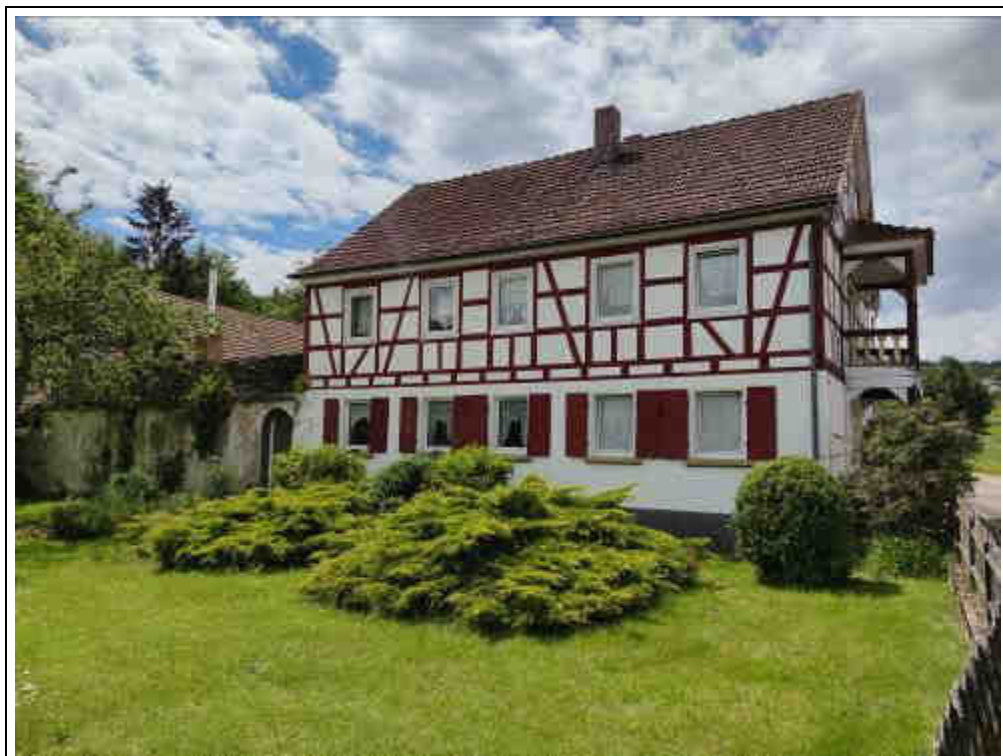
Blick auf das Wohnhaus von Osten
