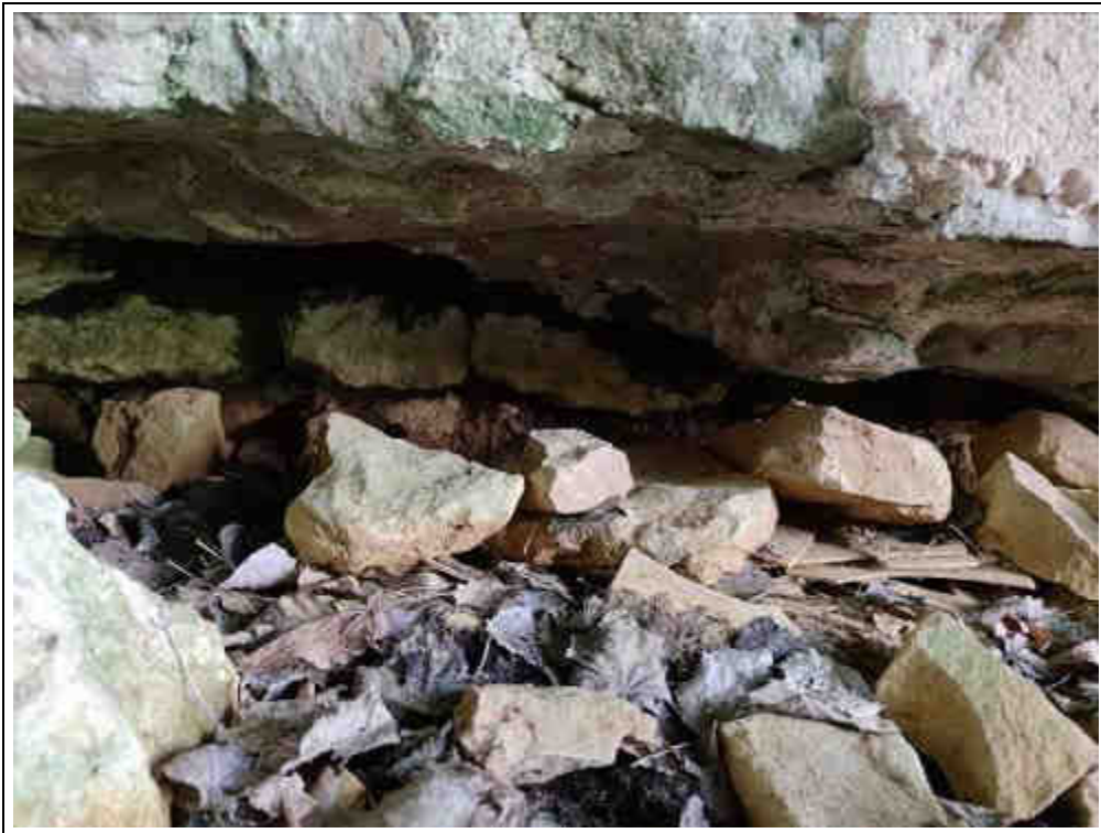
Blick in den Gewölbekeller
