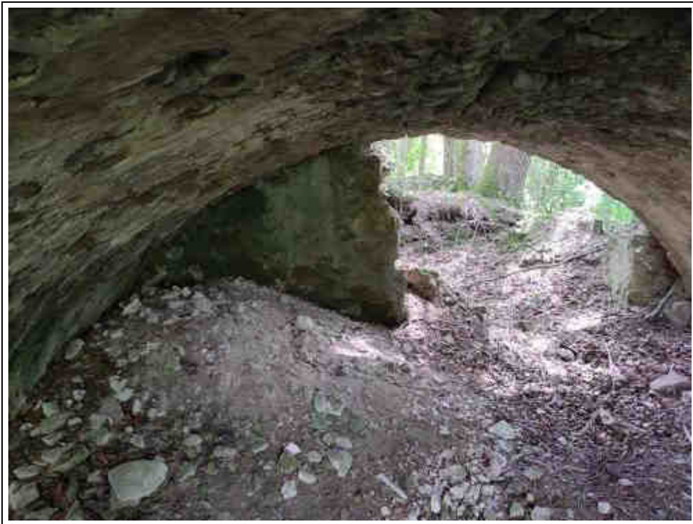
Blick in den Gewölbekeller
