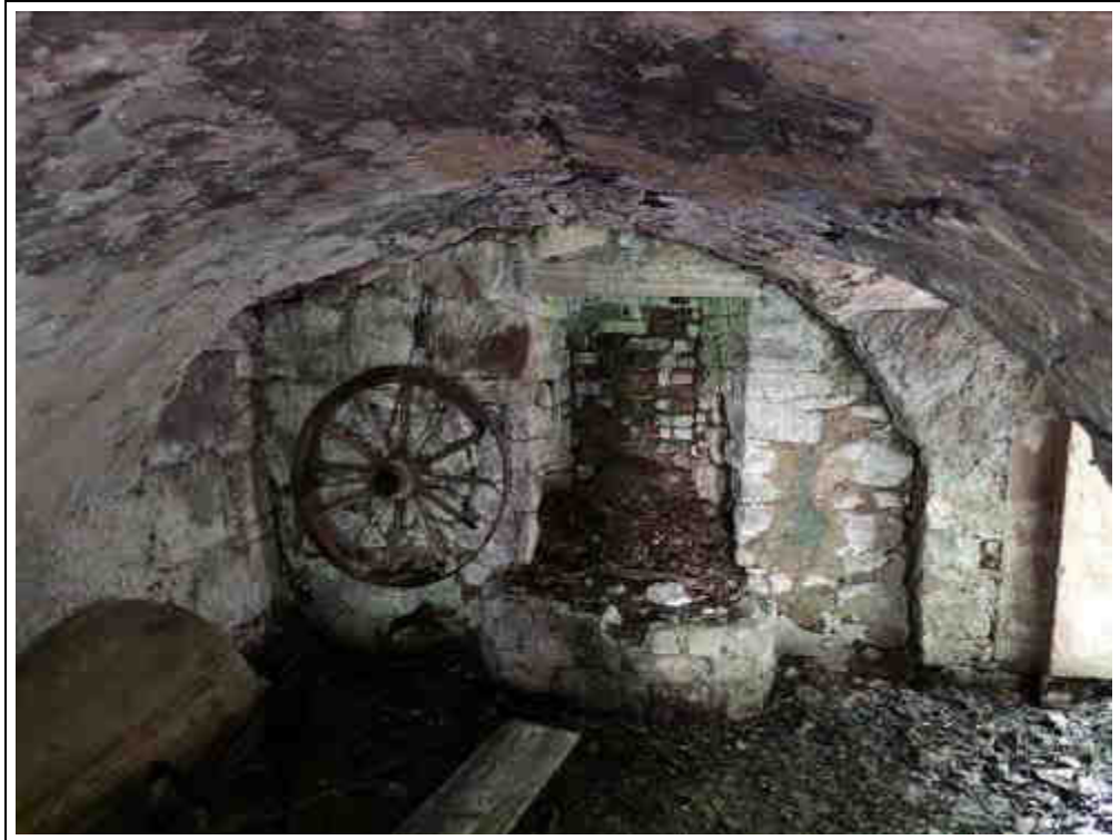
Blick in den Gewölbekeller
