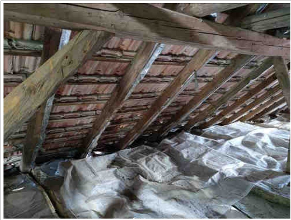
Blick in das Dachgeschoss
