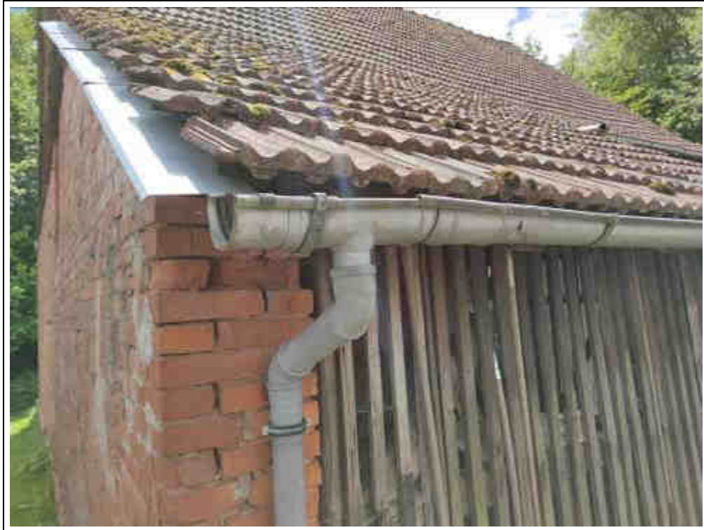
Blick auf die Dachentwässerung der Scheune
