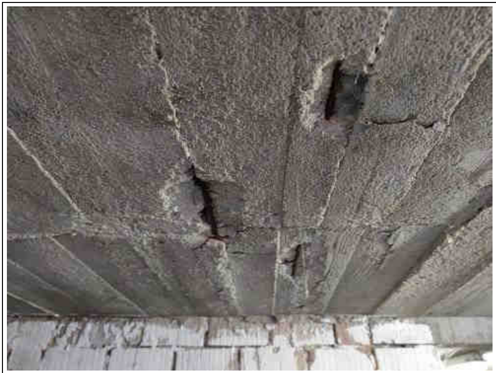
Blick gegen die Stahlbetondecke im Bereich der Garage
