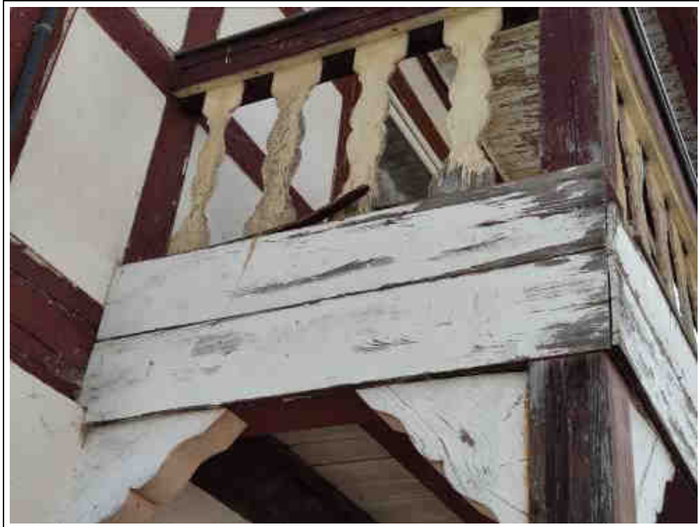
Blick auf den Zustand des Balkons / Eingangüberdachung
