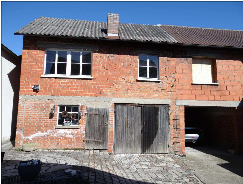
Bild 2: West-Ansicht des Gewerbegebäudes
