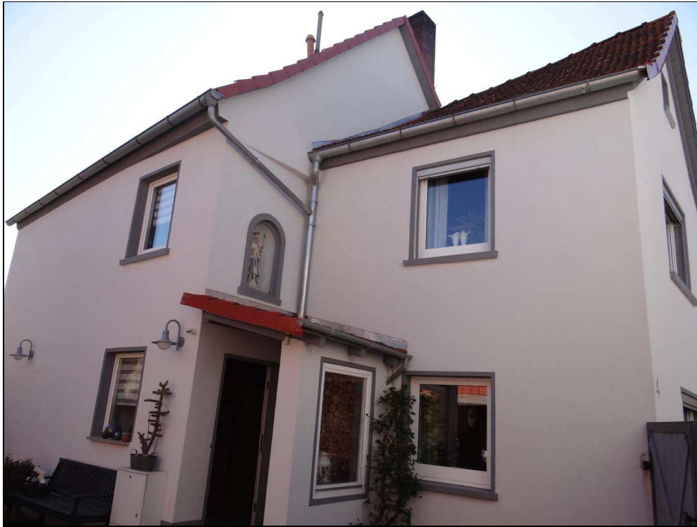
Bild 3: Nord-Ost-Ansicht des Wohngebäudes
