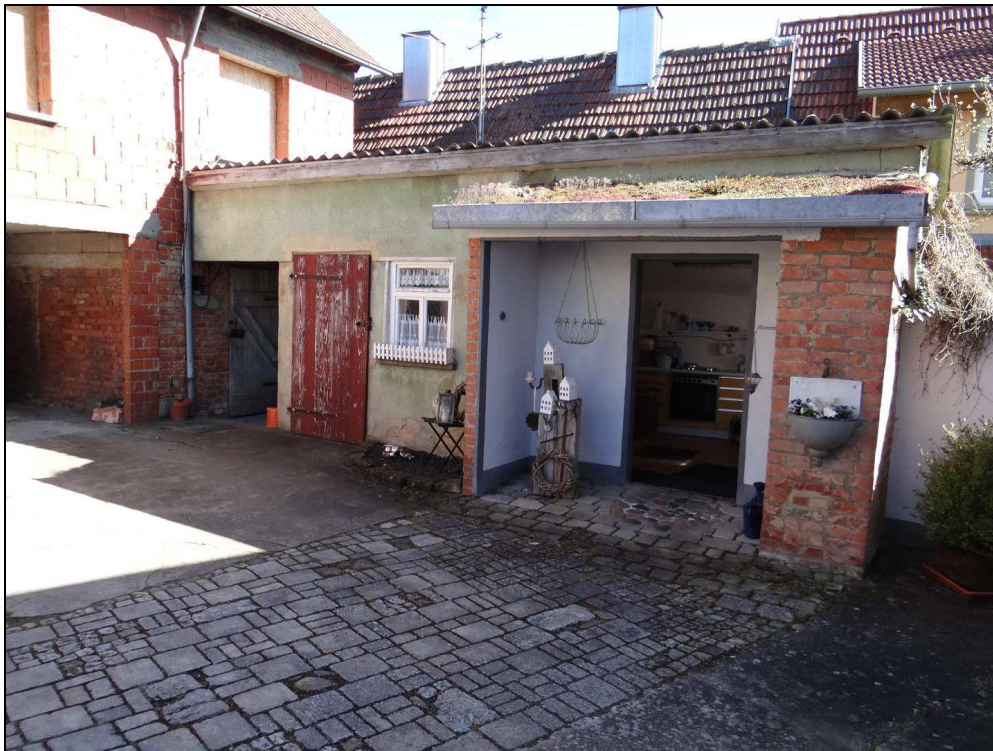
Bild 4: Nord-Ansicht des Wirtschaftsgebäudes
