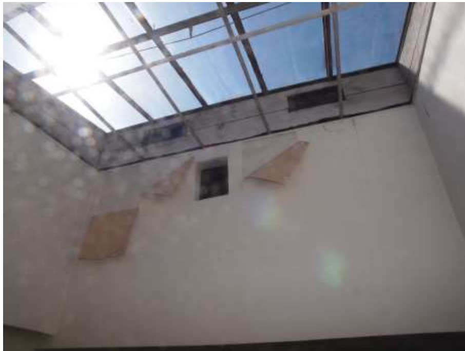
Verglasung im Dach über dem Treppenhaus
