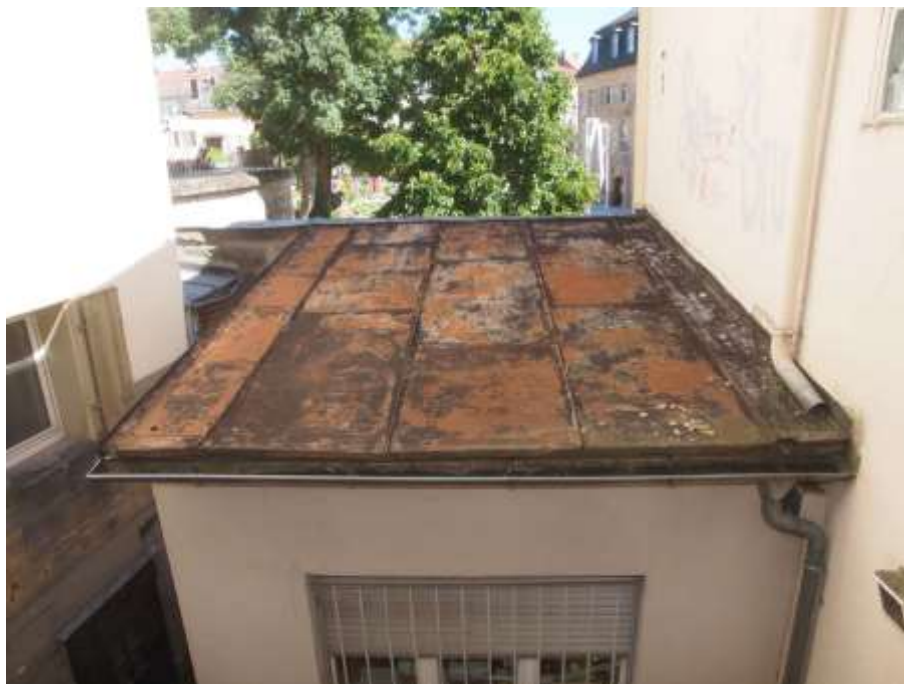
Blick vom 2.OG auf den Zwischenbaukörper
