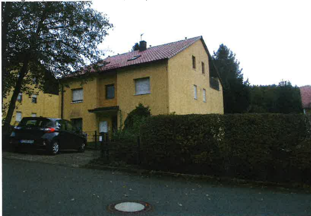
Blick von der Straße zu Haus Nr. 6.
