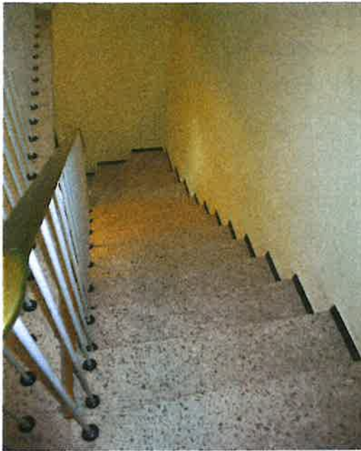
Treppe vom EG zum 1.OG.
