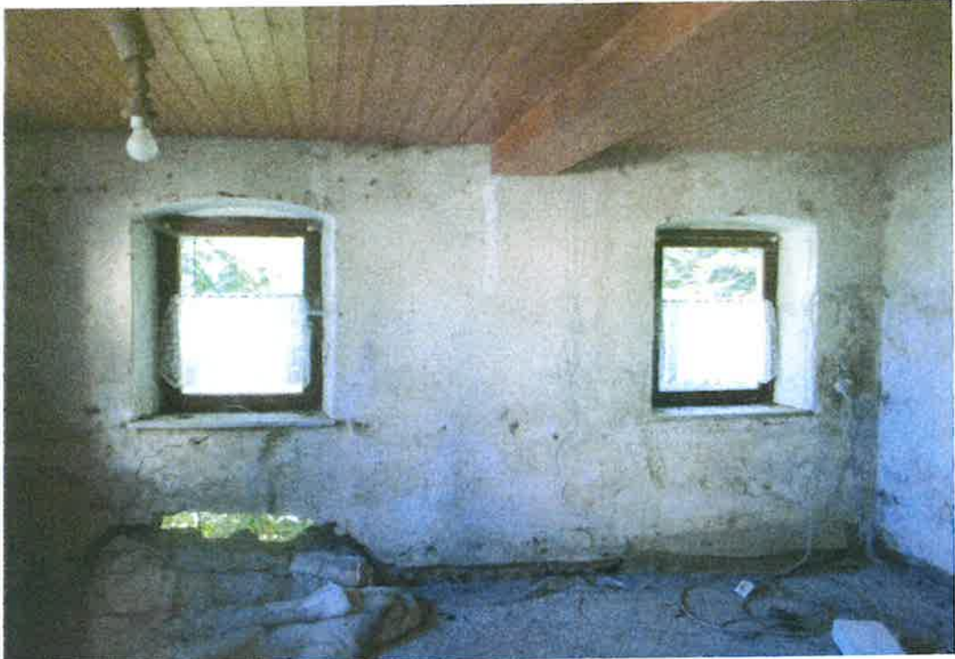
Wohnraum im EG im Rohbauzustand mit Wandloch.
