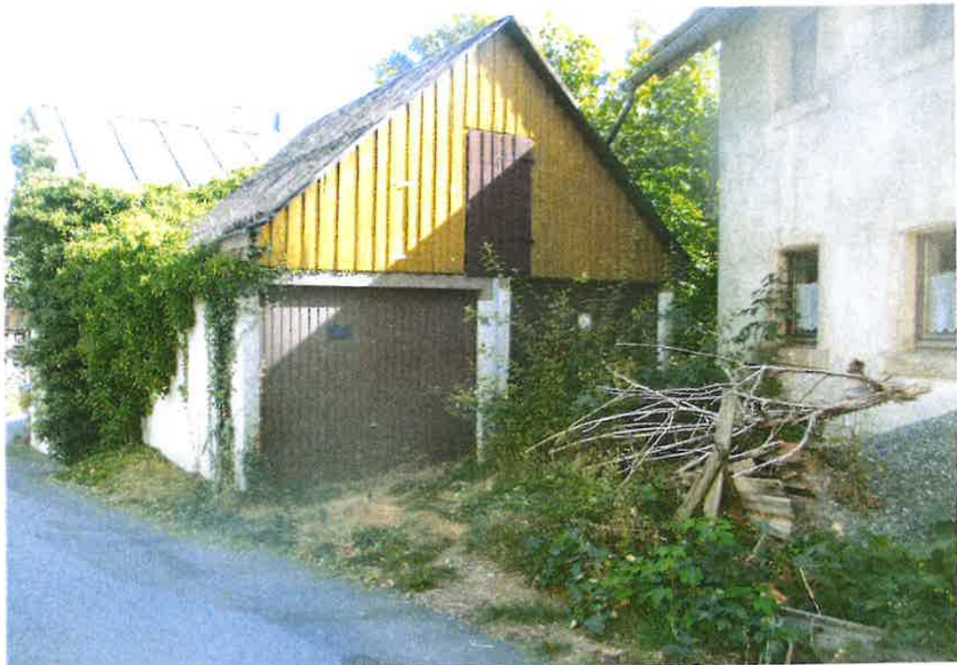
Garage mit verwachsener und verlagerter Zufahrt.
