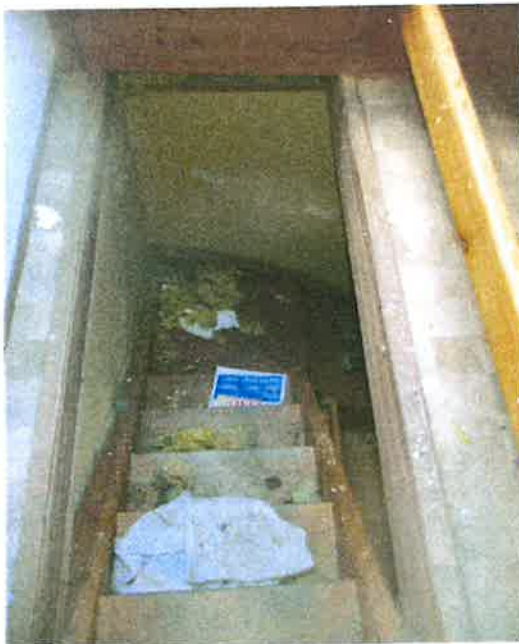
Treppe zum DG.
