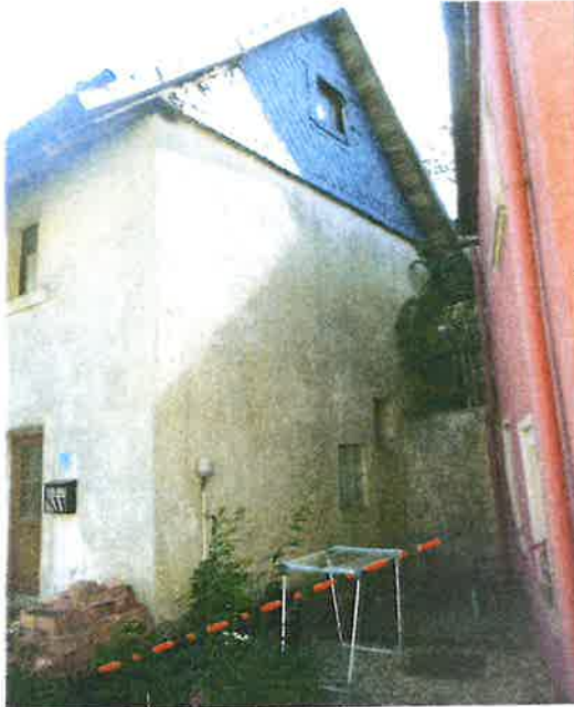
Südwestseite: Die Grundstücksgrenze geht am Haus entlang (rote Linie).
