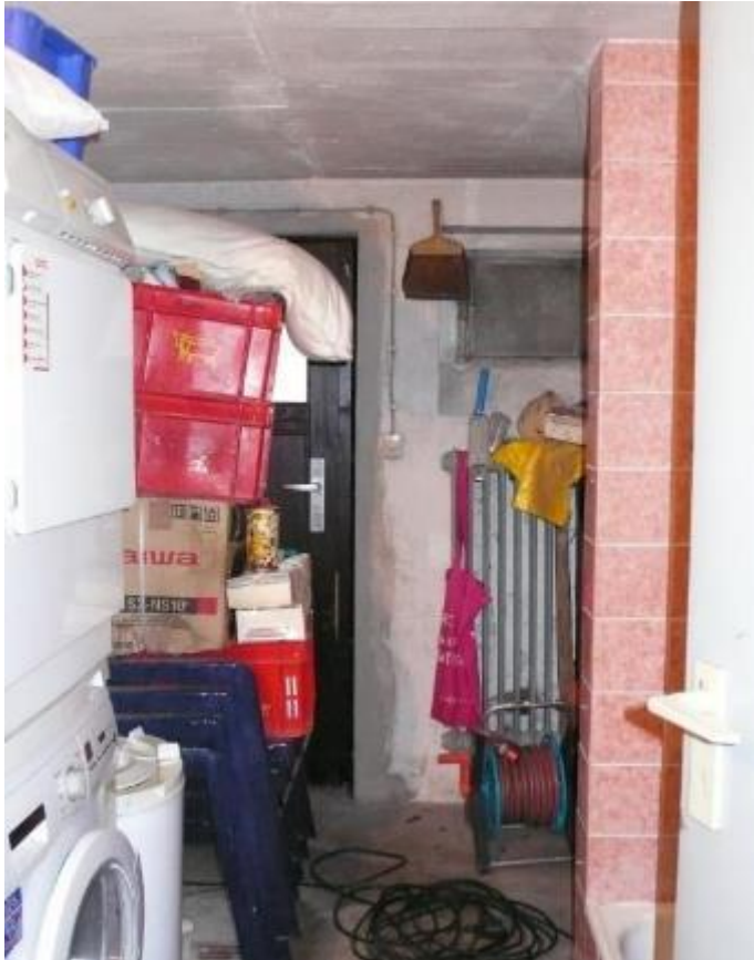
Abbildung 9 KG – Waschküche / Ausgang Kelleraußentreppe
