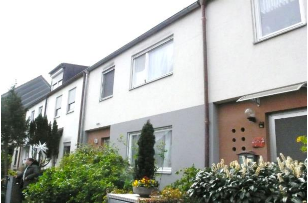
Abbildung 1 Ansicht von Nordosten
