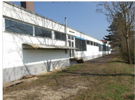
Ansicht von Süden: Büro-Halle
