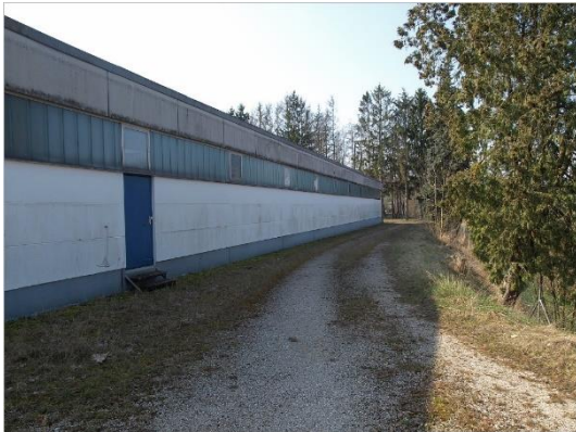
Ansicht von Norden: Anbau-Halle
