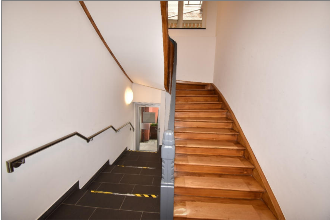
Rathausgasse 4, Erdgeschoss, links Stufen zur Haustür, rechts Treppe zu den Obergeschossen
