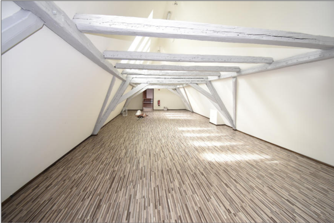
Rathausgasse 4, 2. Obergeschoss, Wohnung Nr. 25, Archiv mit Satteldach in Nord-/Südrichtung
