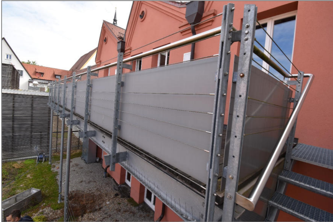
Rathausgasse 4, 2. Obergeschoss, Wohnung Nr. 25, Balkon im Westen, rechts Fluchttreppe
