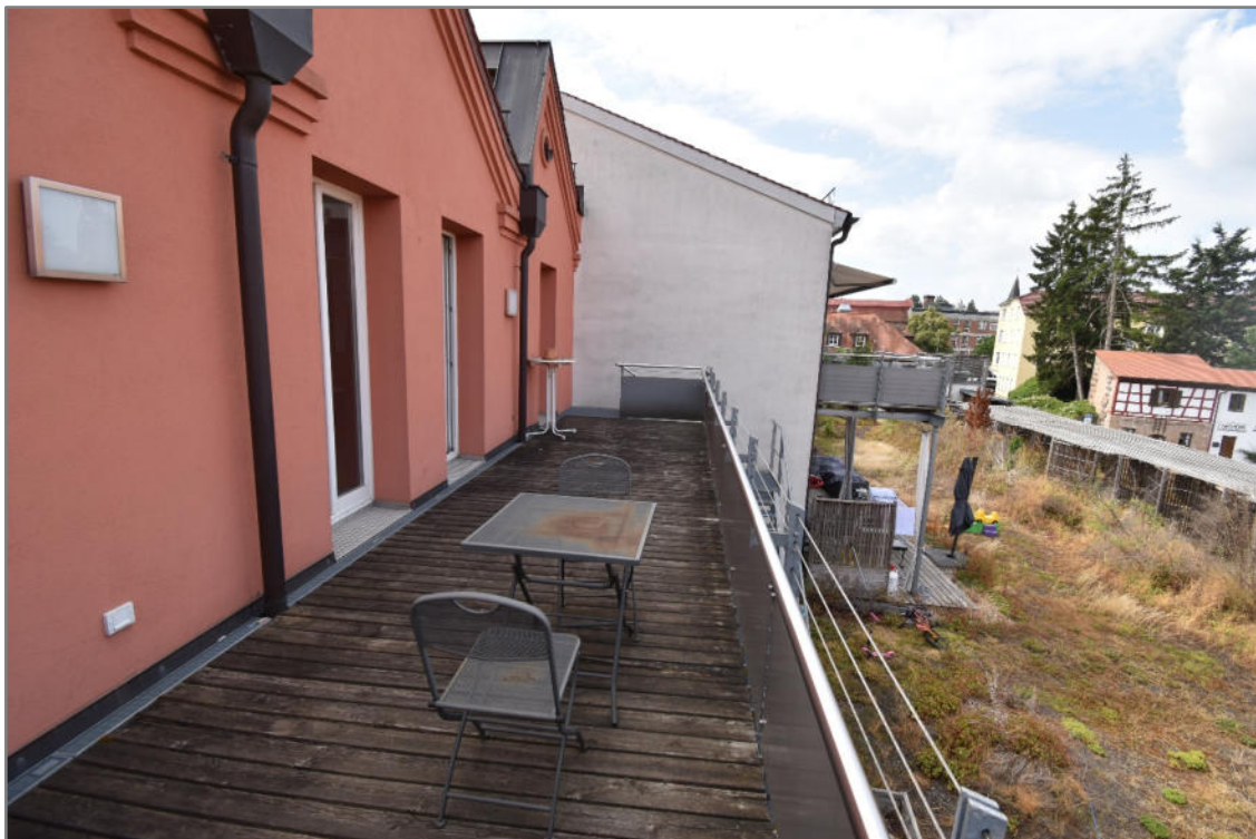
Rathausgasse 4, 2. Obergeschoss, Wohnung Nr. 25, Balkon im Westen, hinten Durchgang zur Fluchttreppe
