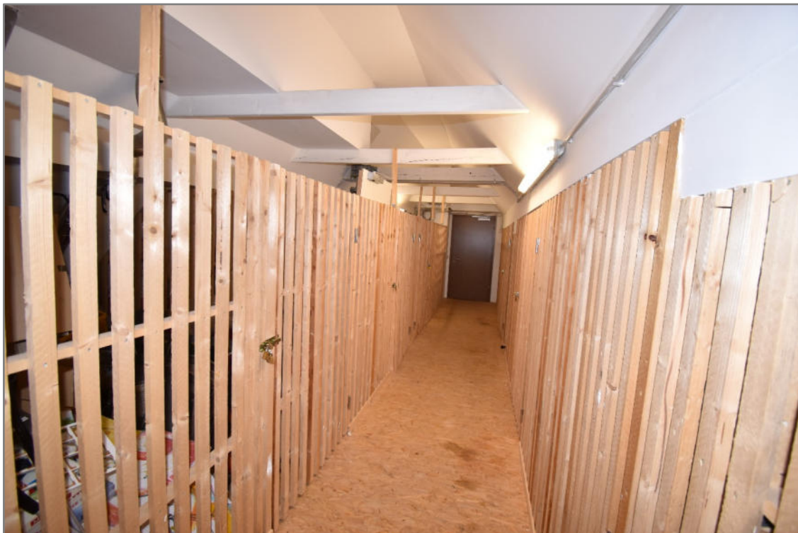
Rathausgasse 4, Dachgeschoss (3. Obergeschoss) mit Dachbodenabteilen
