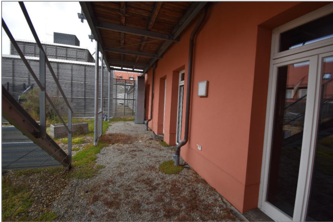
Rathausgasse 4, 1. Obergeschoss, Wohnung Nr. 15, Terrasse im Westen auf dem Flachdach des Gebäudes B2
