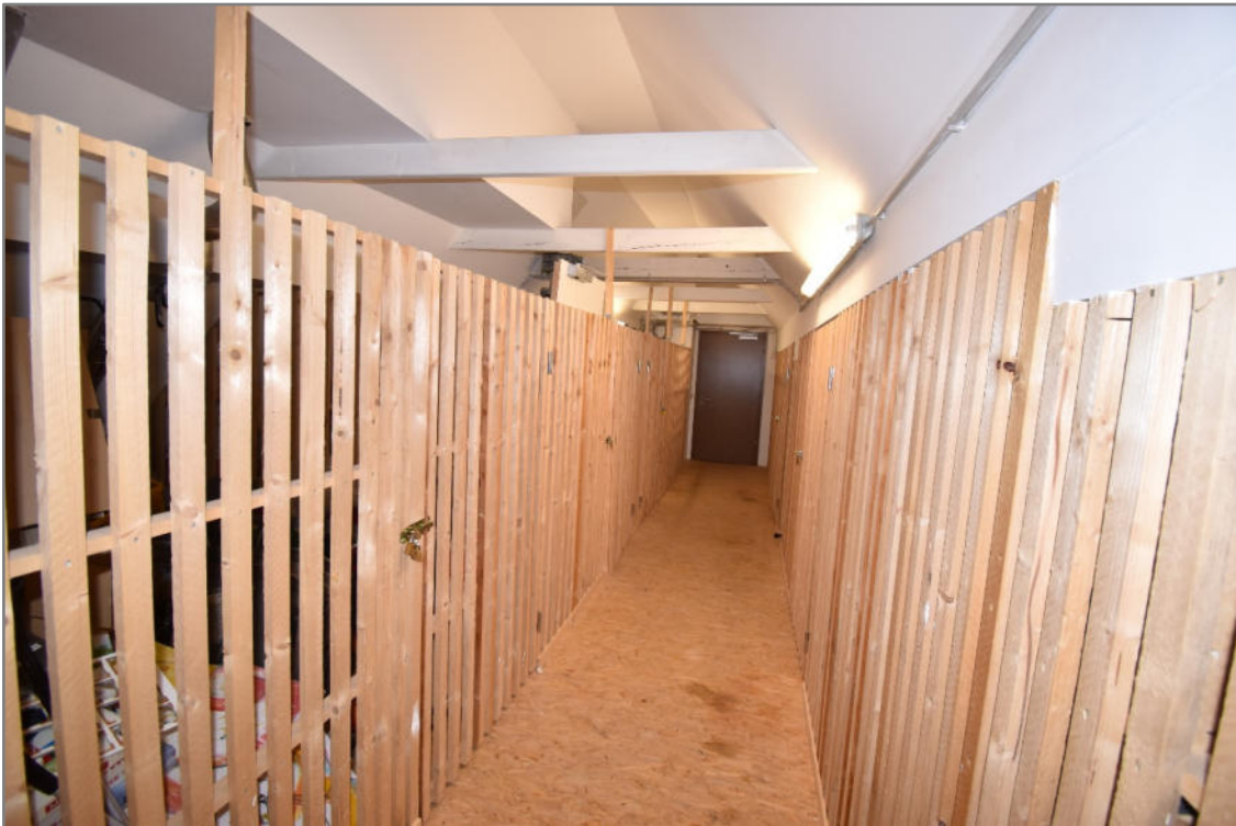
Rathausgasse 4, Dachgeschoss (3. Obergeschoss) mit Dachbodenabteilen
