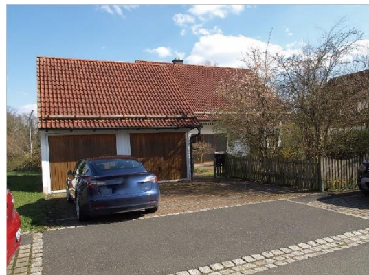
Ansicht Garage von Westen
