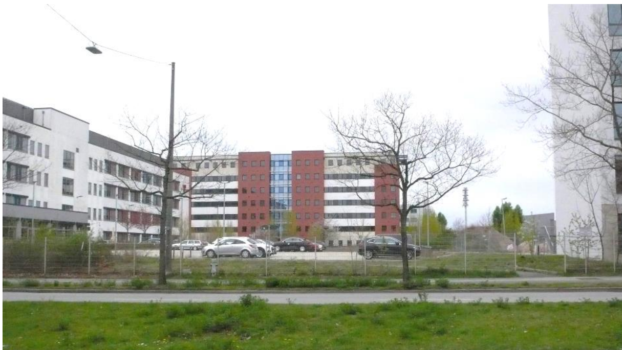
Abbildung 7 Bewertungsgegenstand IV - Baufläche - Flurstück Nr. 316/15 - Ansicht von Osten/Hansastraße
