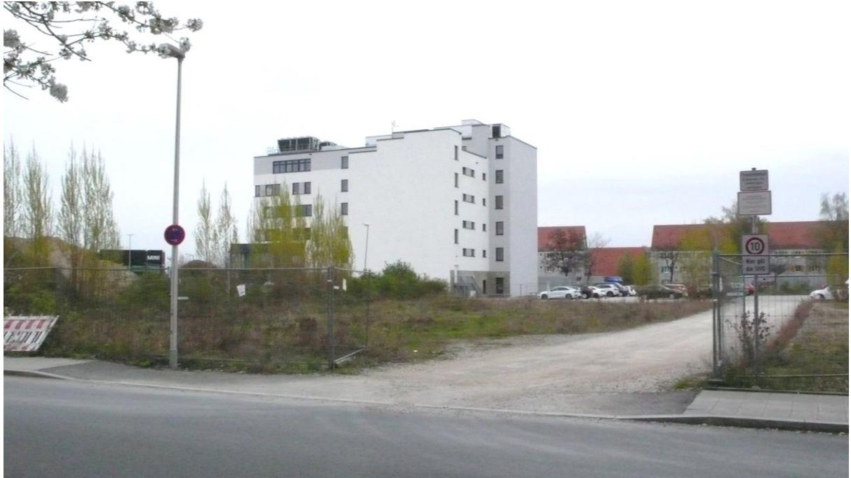
Abbildung 4 Bewertungsgegenstand IV - Baufläche - Flurstück Nr. 316/15 - - Ansicht von Westen
