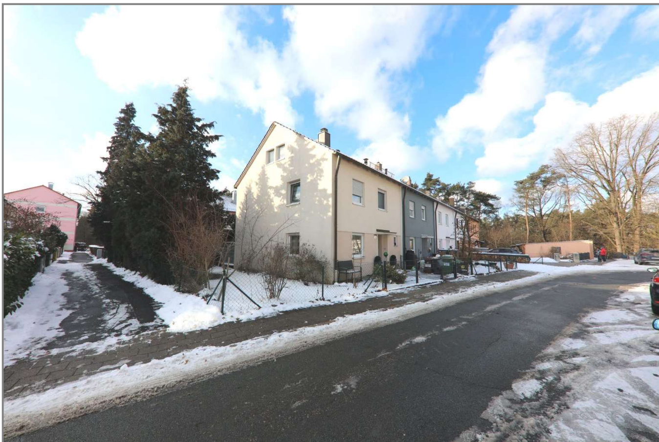
Schlesierstraße vor Bewertungsobjekt, Blick Nordwest
