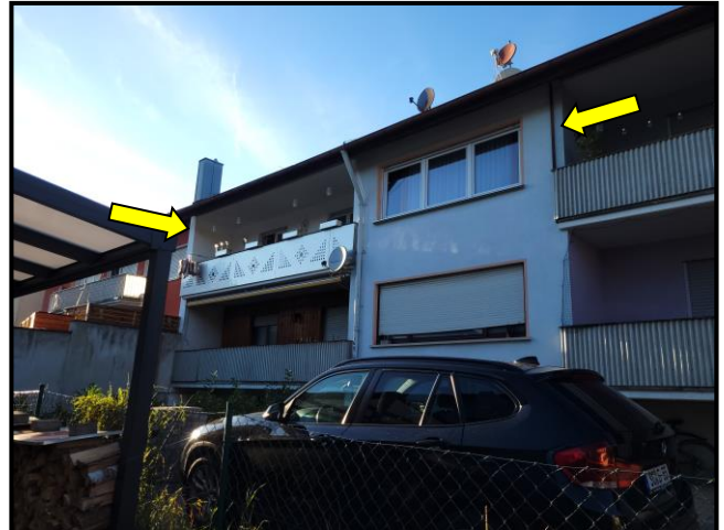
Teilansicht Südfassade mit Lage der Wohnung SOE Nr. 2
