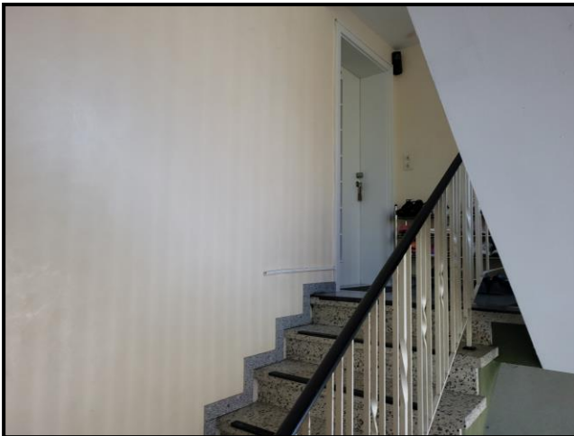
Beispiel für Innenansicht und Objektzustand: Treppenhaus im Bereich OG
