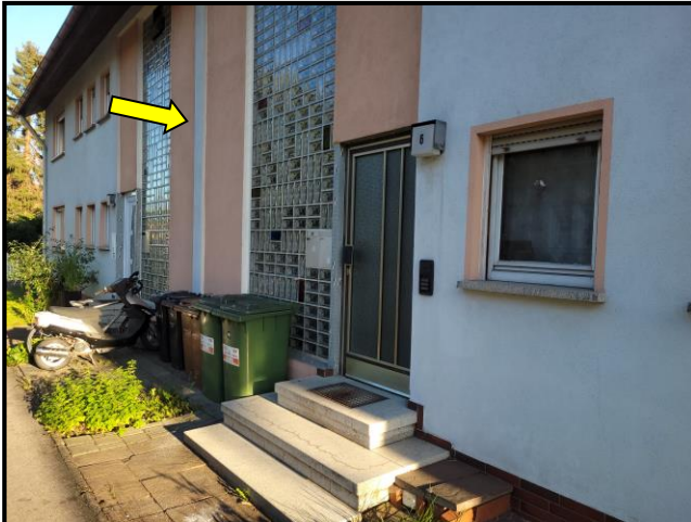
Teilansicht Nordfassade mit Hauseingang
