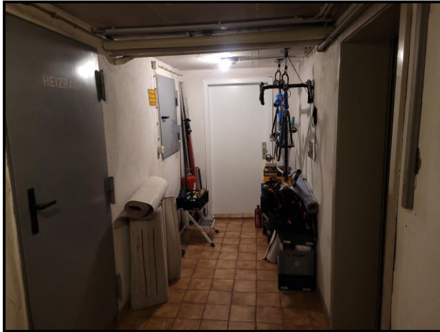
Beispiel für Innenansicht und Objektzustand: Gang im Bereich KG
