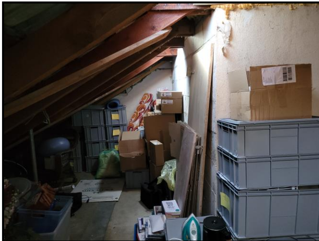
Beispiel für Innenansicht und Objektzustand: DG, Gemeinschaftseigentum
