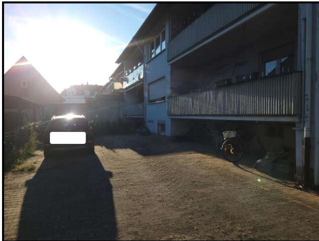
Beispiel für Objektzustand: Hofffläche südlich des Gebäudes Sandstraße 6 und 6a
