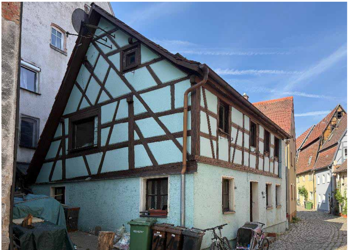
Abbildung 2 Ansicht von Nordosten
