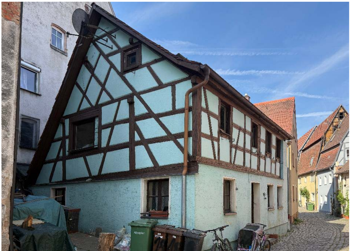
Abbildung 2 Ansicht von Nordosten
