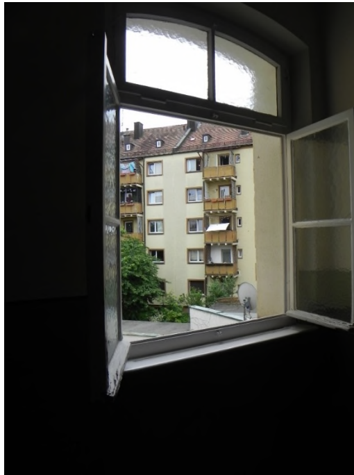
Fenster im Treppenhaus
