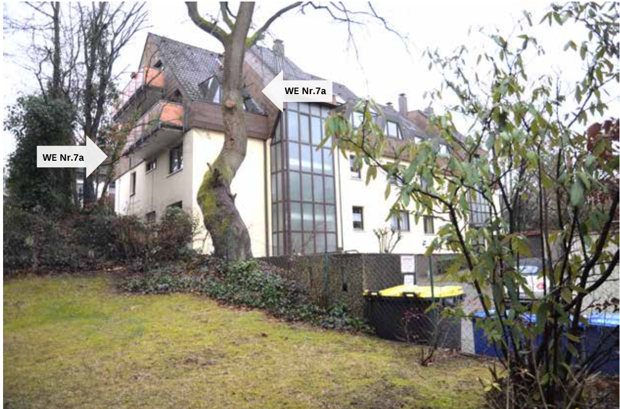
Abbildung 1 Ansicht von Nordosten
