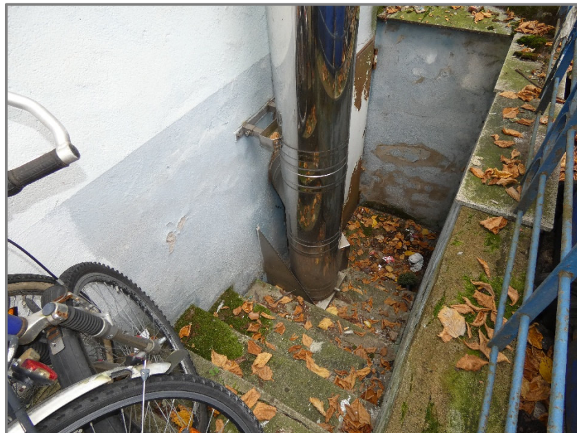
nordöstlicher Grundstücksbereich - Kelleraußentreppe zum Heizungsraum
