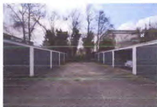
Garagenhof angrenzend im Norden
