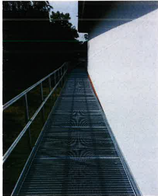
Ostansicht mit Rampe für Rollstuhlfahrer und Krankentransporte
