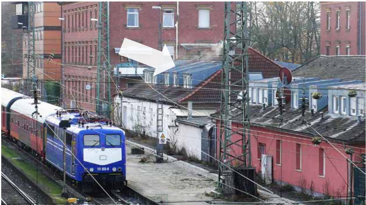
Abbildung 4 Ansicht von Nordwesten / von der Brücke der Katzwanger Straße
