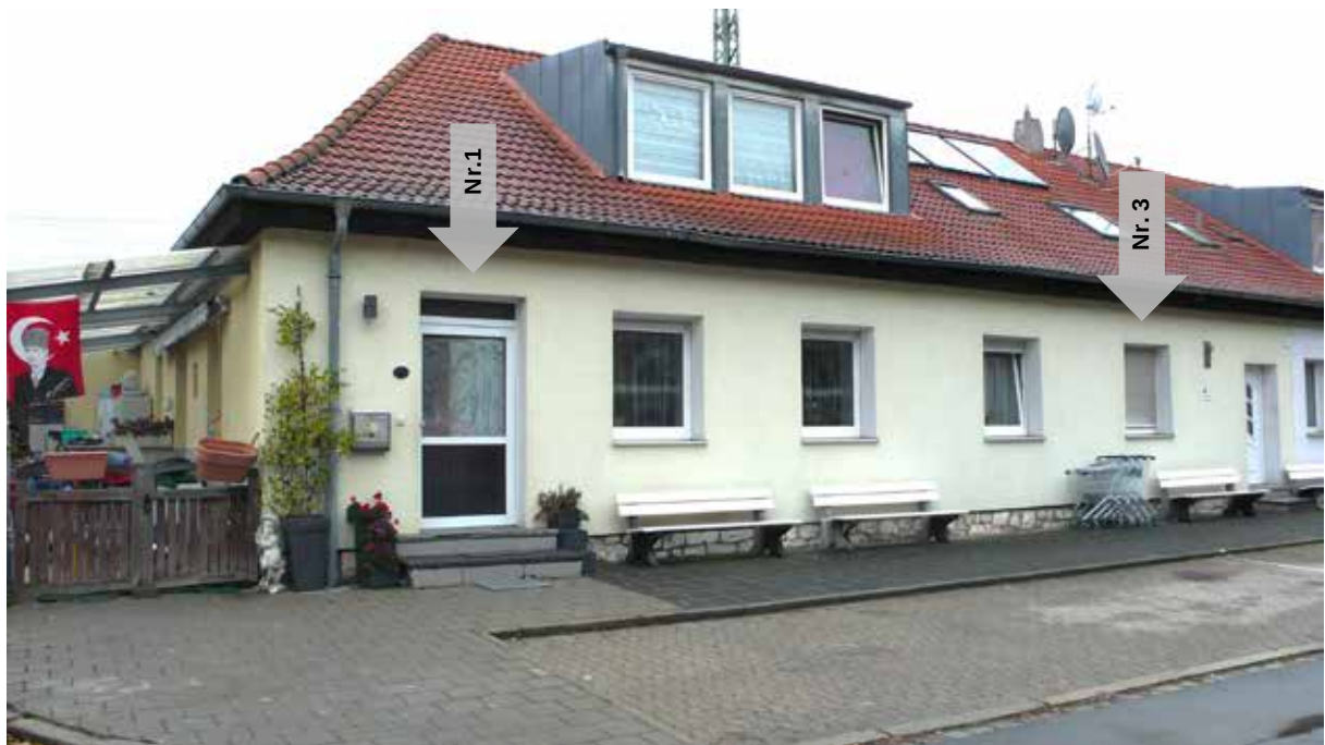
Abbildung 2 Ansicht von Südwesten
