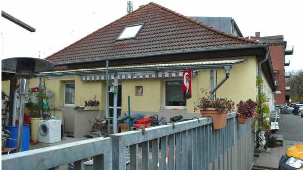
Abbildung 3 Ansicht von Westen / genutzte Freifläche
