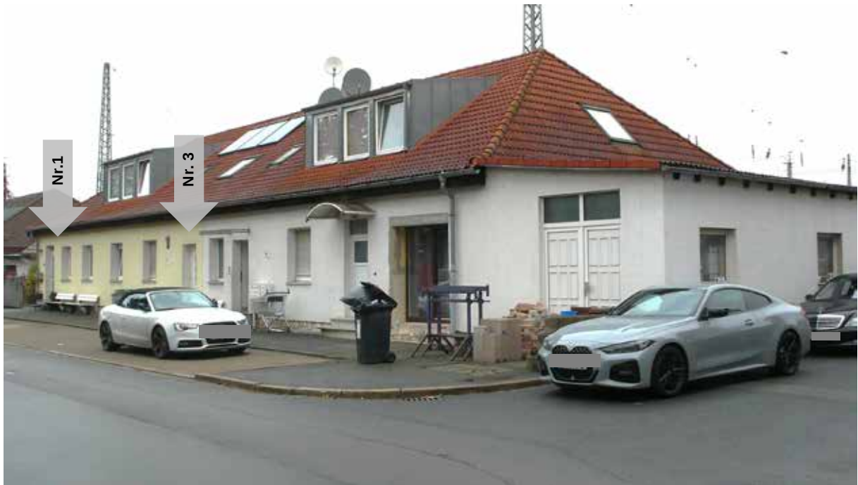
Abbildung 1 Ansicht von Südosten / rechtseitig Anbau (auf Nachbargrundstück)
