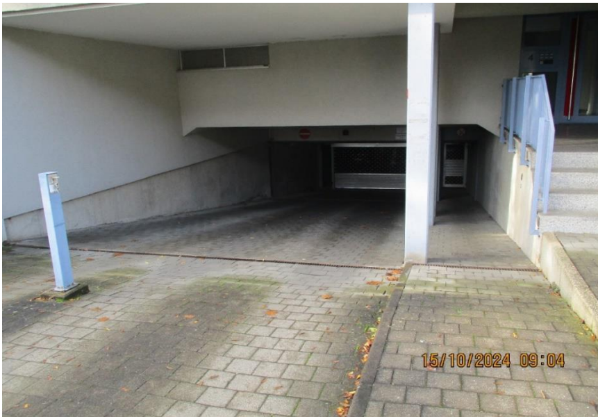
Einfahrt, überdachte Rampe
