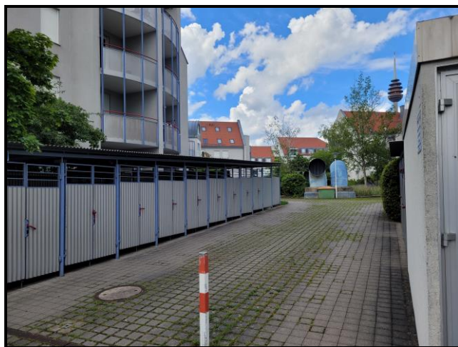
Blick von der Prager Straße in den Innenhof der Wohnanlage
