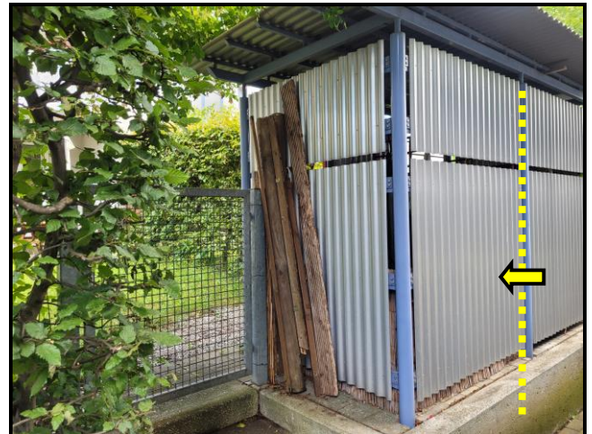
Überdachte Einstellmöglichkeit im Bereich des Sondernutzungsrechts der Wohnung SOE Nr. 13
