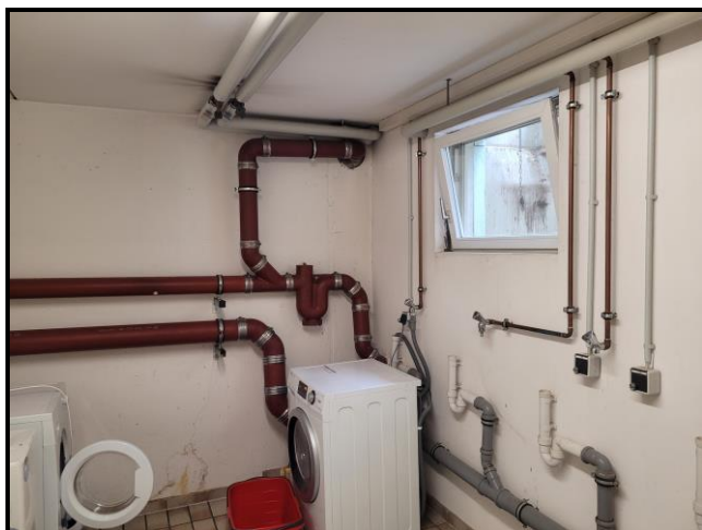
Beispiel für Innenansicht und Objektzustand: Waschmaschinenraum KG
