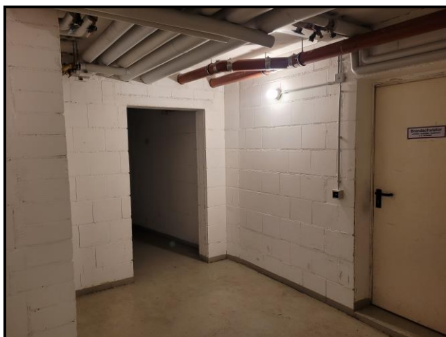
Beispiel für Innenansicht und Objektzustand: Kellergang
