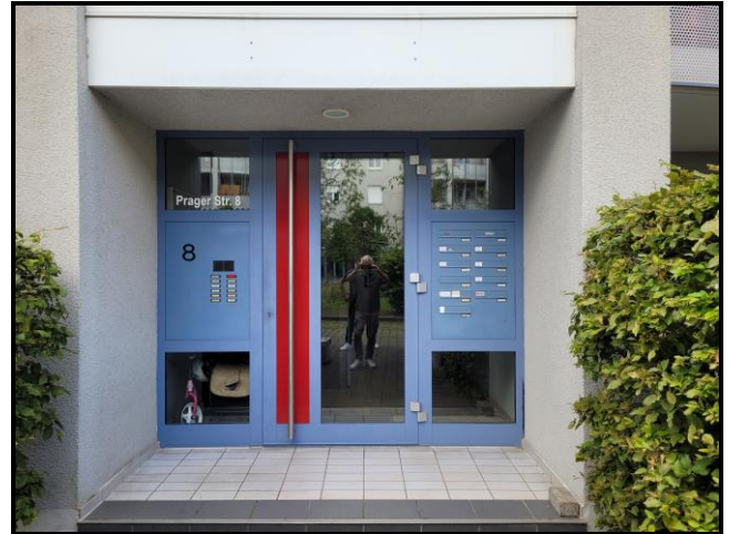
Eingangsbereich des Gebäudes Prager Straße 8 (Ostfassade)
