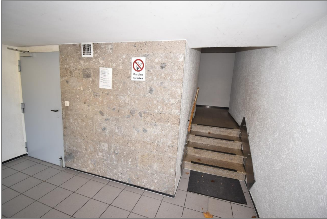
Eingangspodest, links Tür zum Kellergeschoss
