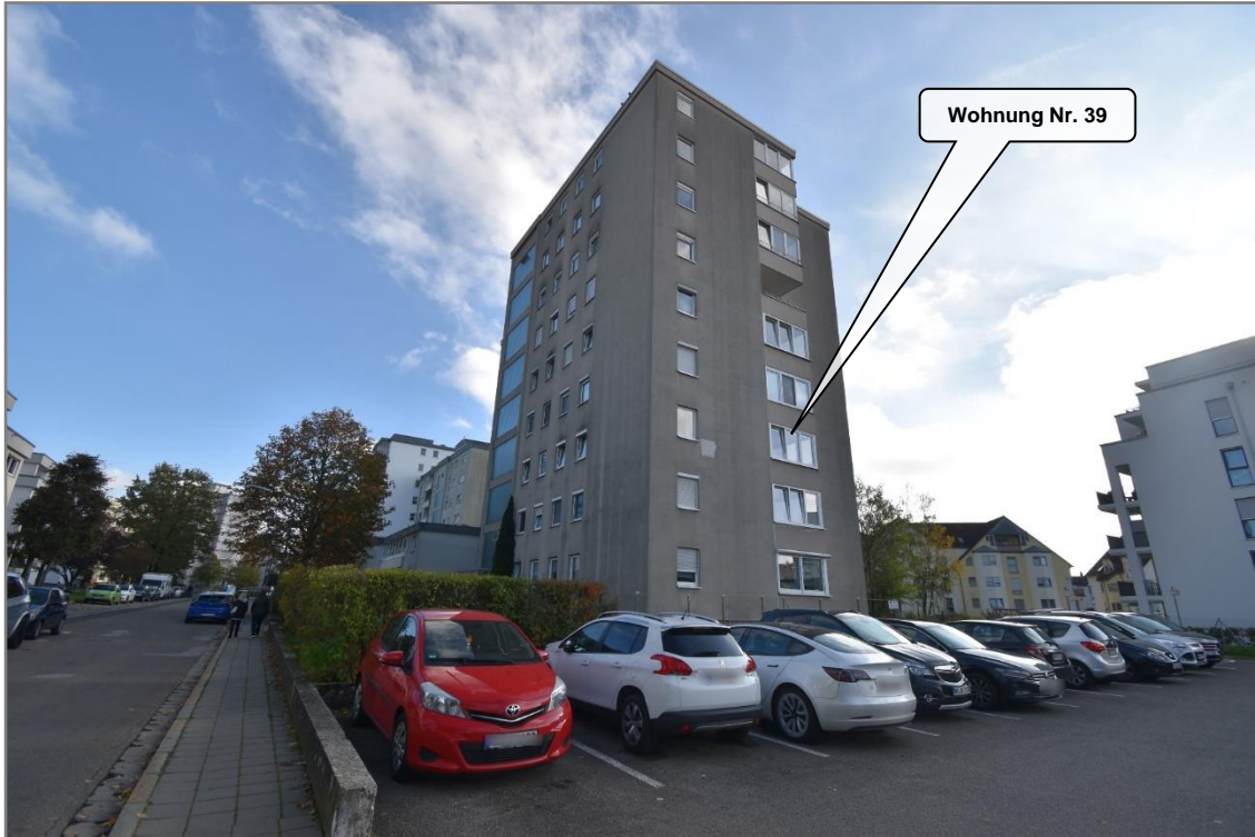
Blick vom Bürgersteig der Seelstraße aus nach Südosten auf das Wohnhaus Seelstraße 29
