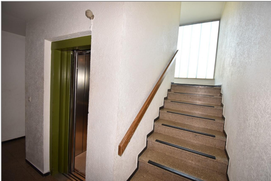
Treppenpodest Erdgeschoss, Aufzug und Treppenlauf zu den oberen Geschossen
