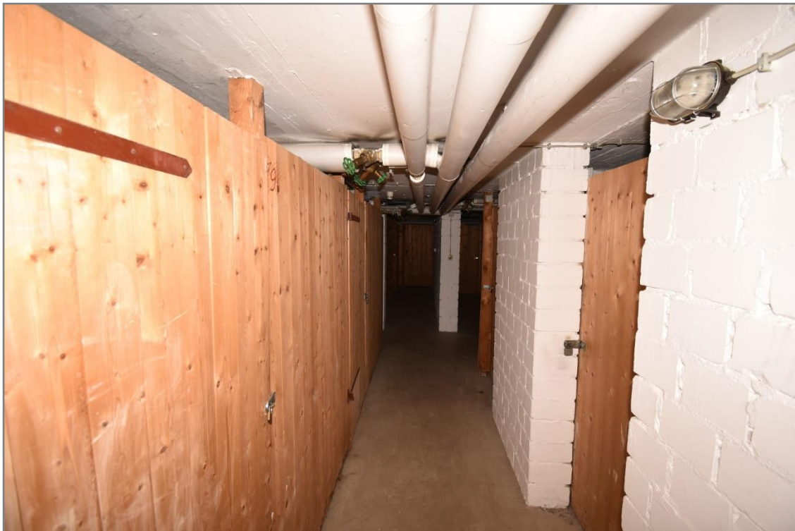
Kellergeschoss, mit Bretterwänden abgetrennte Kellerabteile
