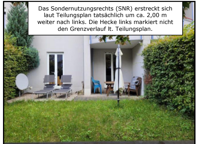
Teilansicht Westfassade des Gebäudes Prager Straße 8 im Bereich des Sondernutzungsrechts West der Wohnung SOE Nr. 12
