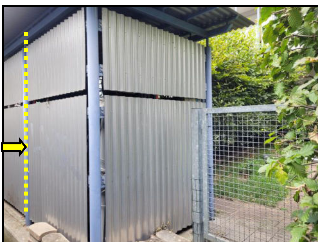
Überdachte Einstellmöglichkeit im Bereich des Sondernutzungsrechts der Wohnung SOE Nr. 12
