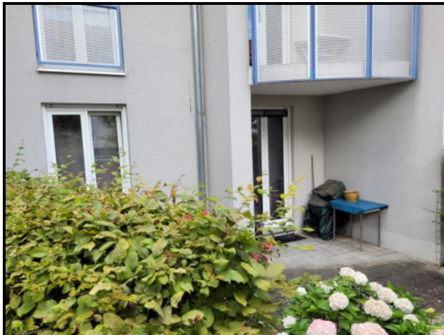
Teilansicht Ostfassade des Gebäudes Prager Straße 8 im Bereich des Sondernutzungsrechts Ost der Wohnung SOE Nr. 12
