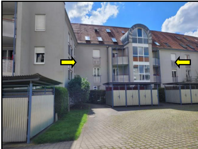
Ostfassade des Gebäudes Prager Straße 8 vom Innenhof der Wohnanlage aus gesehen
