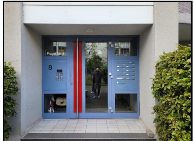
Eingangsbereich des Gebäudes Prager Straße 8 (Ostfassade)
