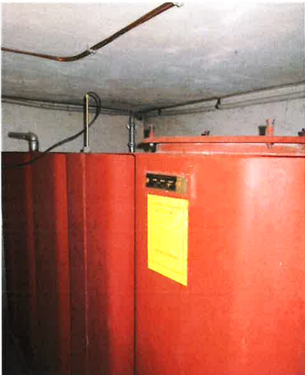
Öltank (zum Rückbau)
