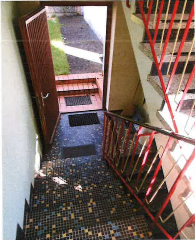
Treppe EG > Zwischenpodest und Gartentür
