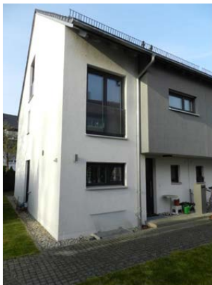
Ansicht von Nordost, Hauseingang
