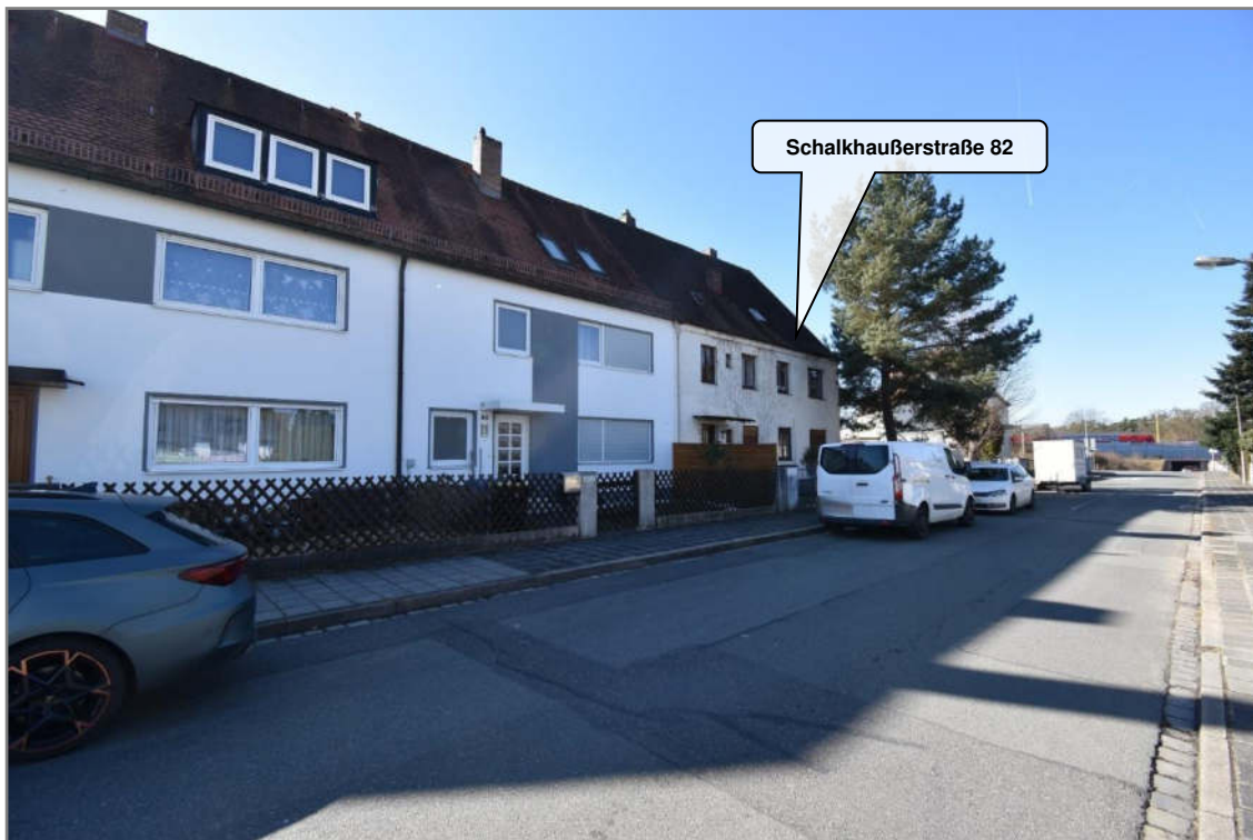
Blick über die Schalkhaußerstraße nach Nordwesten auf das Bewertungsgrundstück
