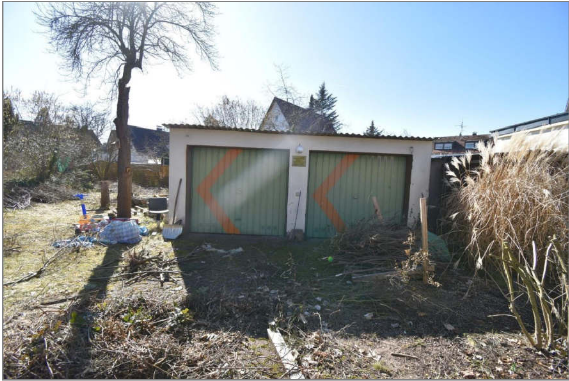
Schalkhaußerstraße 82, Doppelgarage an der Nordwestgrenze
