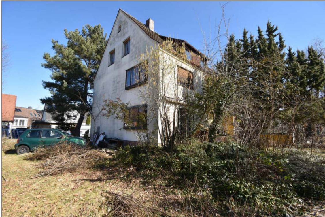
Schalkhaußerstraße 82, Blick nach Osten auf die nordwestliche Giebel- und die südwestliche Traufseite des Wohnhauses
