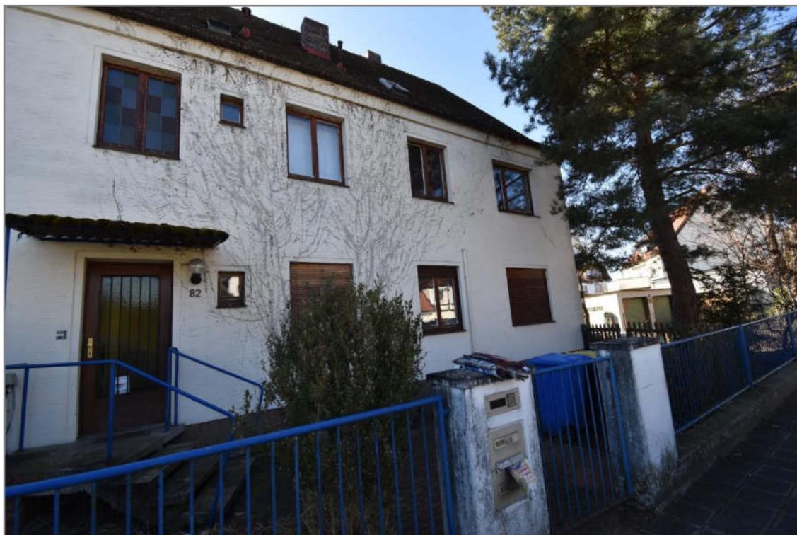
Blick vom Bürgersteig der Schalkhaußerstraße aus auf die nordöstliche Traufseite des Wohnhauses mit Hauseingang
