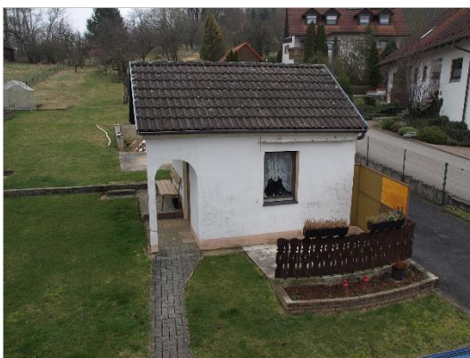
Draufsicht ehem. Waschhaus
