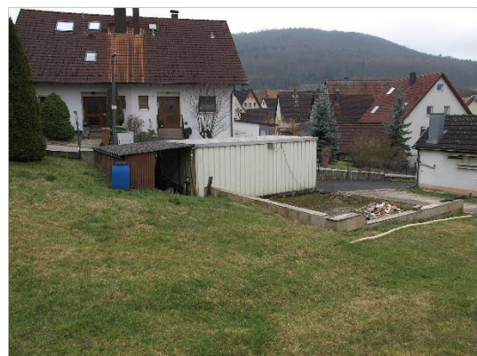
Ansicht Garage von Norden
