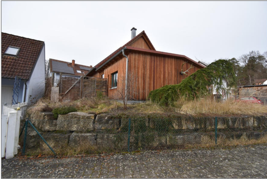
Tulpenweg 1, Blick von der mit einem Geh- u. Fahrrecht und weiteren Rechten belasteten Fläche aus nach Westen
