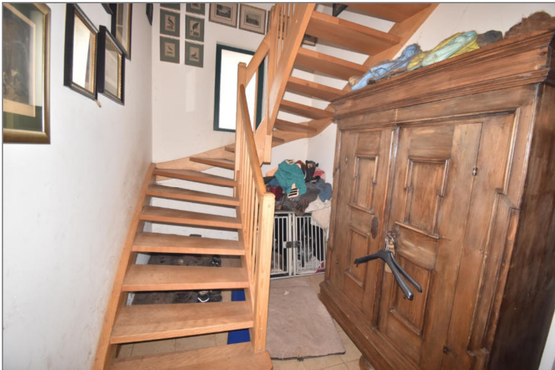
Wohnhaus, Treppe vom Erd- zum Dachgeschoss
