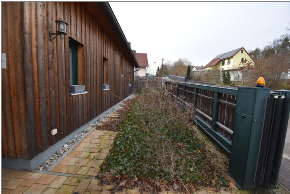
Tulpenweg 1, Blick nach Westen auf den Vorgarten zwischen Wohnhaus und Nordgrenze
