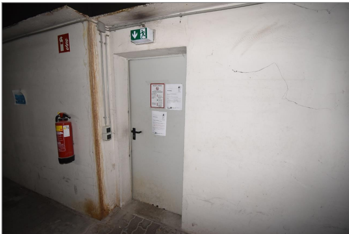
Zugang von der Tiefgarage aus zum Keller Haus Nr. 1c
