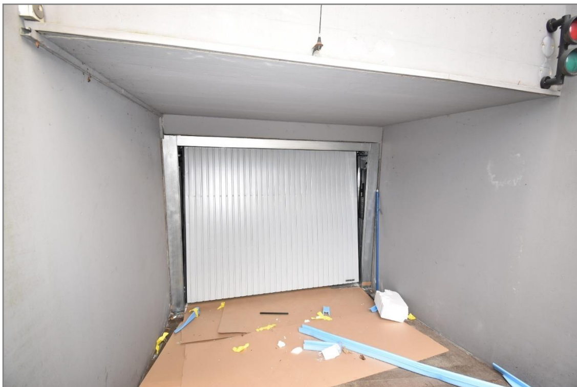
Zufahrt zur Tiefgarage, neues Schwingtor wird eingebaut
