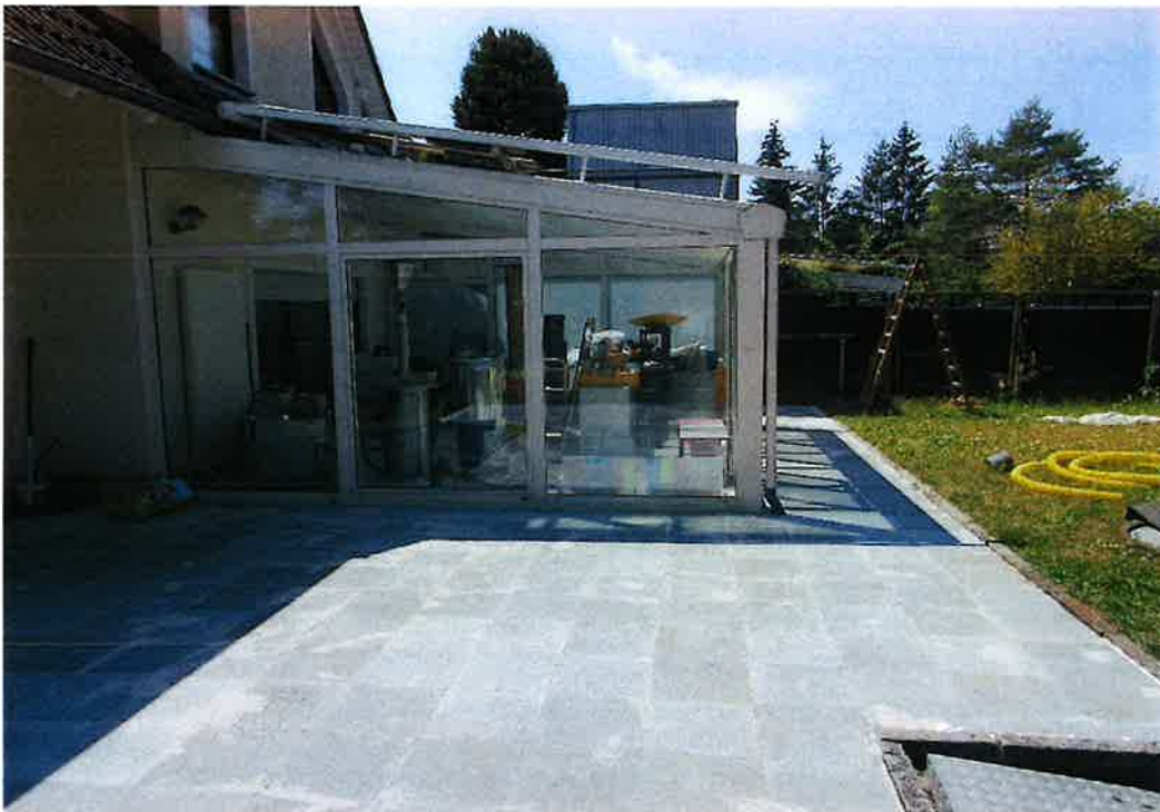
Terrasse und Wintergarten
