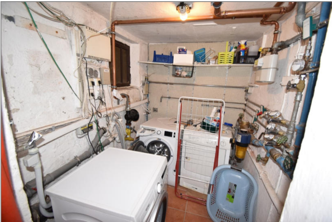
Ebenseestraße 9, Kellergeschoss, Hausanschluss-/Waschmaschinenraum, Waschmaschinenstellplätze
