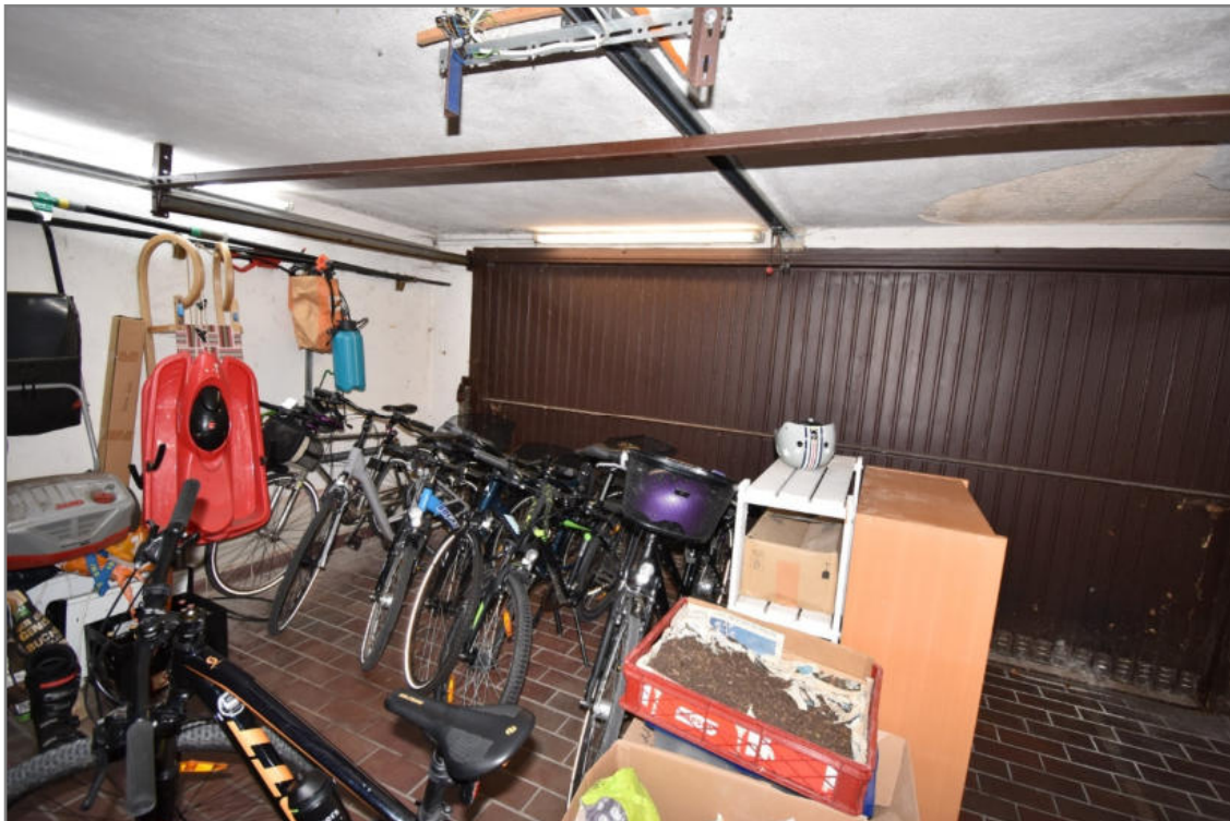
Ebenseestraße 9, Doppelgarage, SNR der rechtsseitigen Hälfte für die Wohnungen Nr. 1, 2 und 3
