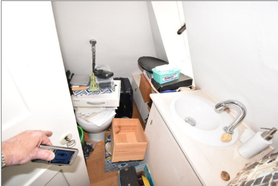
Ebenseestraße 9, Dachgeschoss, Wohnung Nr. 3, WC
