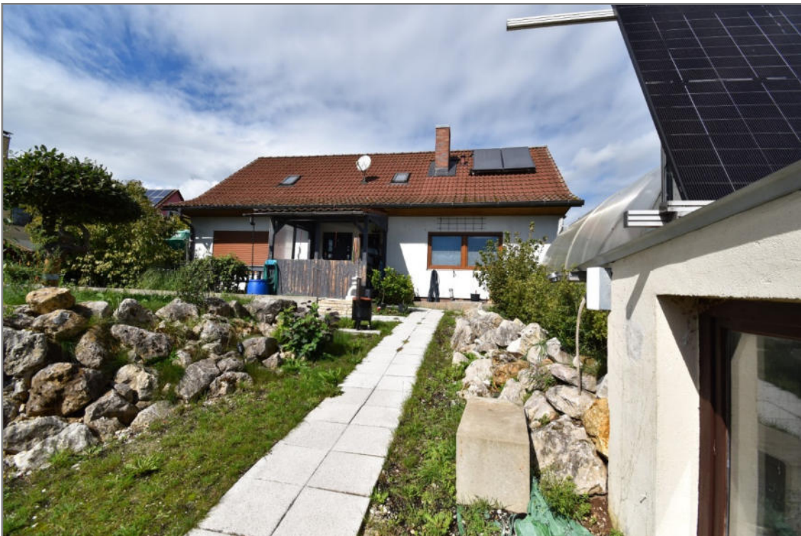
Heidenbergstraße 2, Blick nach Nordwesten auf die südliche Traufseite des Wohnhauses mit Eingangsbereich
