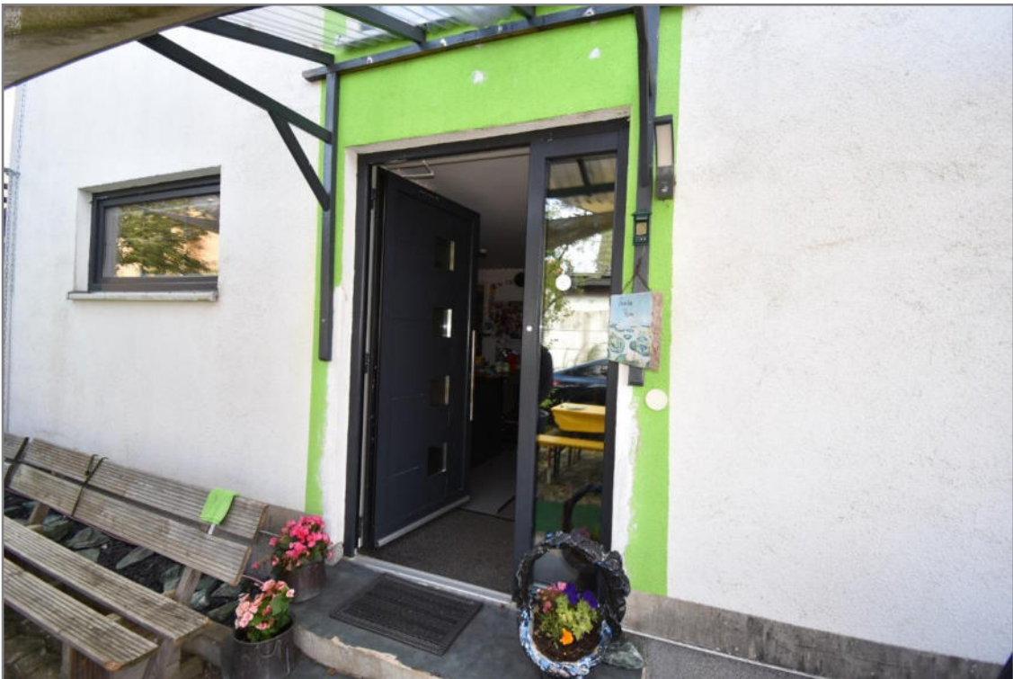
Weiherweg 11, Hauseingang an der Westseite des Wohnhauses
