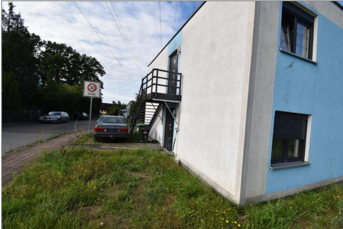
Weiherweg 11, Freifläche im Osten mit Holzaußentreppe am Wohnhaus
