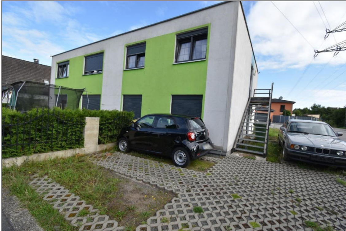
Weiherweg 11, Blick nach Nordwesten auf das Wohnhaus
